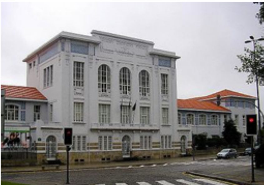
Fig. 12 - Escola Secundária Rodrigues de Freitas - Porto
