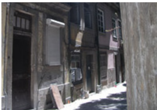
Fig. 3 - Edifício em ruínas - Rua de D. Hugo
