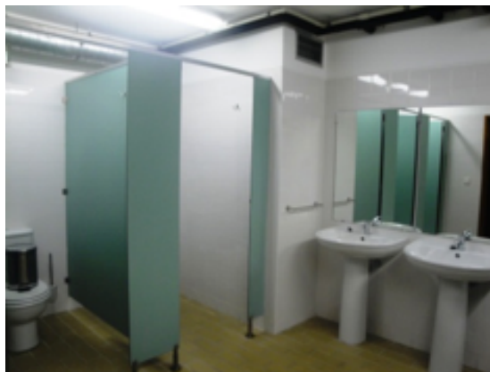
Fig. 27 - Casa de banho colectiva
