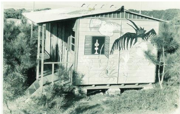
Fig. 93 - Casa de madeira no terreno da Casa da Carruagem, pintada por Henrique Silva | c. 1970 | C.F.: Ursula Zangger
