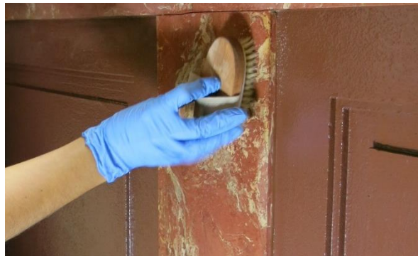
Fig. 117 – Limpeza com solventes | Interior da balaustrada em escaiola do Banco de Portugal, no Porto | C.F.: A.P.
