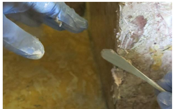
Fig. 118 – Reconstituições volumétricas | Interior da balaustrada em escaiola do Banco de Portugal, no Porto | C.F.: Nancy Fonseca
