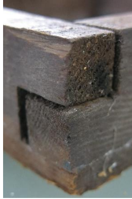
Fig. 56 - Sistema de ligação dos cantos da moldura | A.P.
