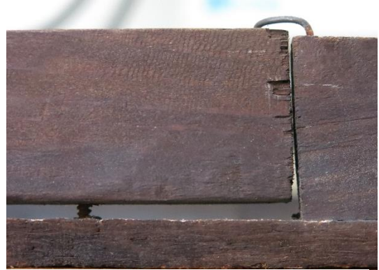
Fig. 57 - Sistema de ligação das ripas de madeira laterais da moldura entre si e ao suporte | A.P.
