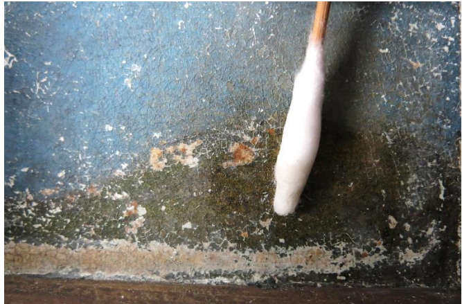
Fig. 84 - Limpeza superficial da zona de tom azul com spray dourado | A.P.
