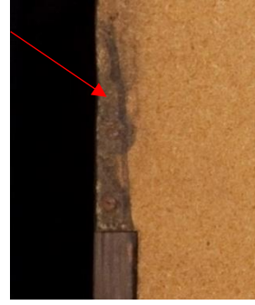
Fig. 43 - Mancha de tinta na extremidade do suporte da obra resultante da sua aplicação sobre o suporte lenhoso da moldura | C.F.: Gonçalo Figueiredo (LabFoto do Lab.IPT)
