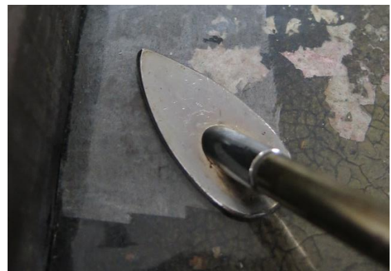
Fig. 81 – Activação do adesivo com espátula eléctrica térmica | A.P.
