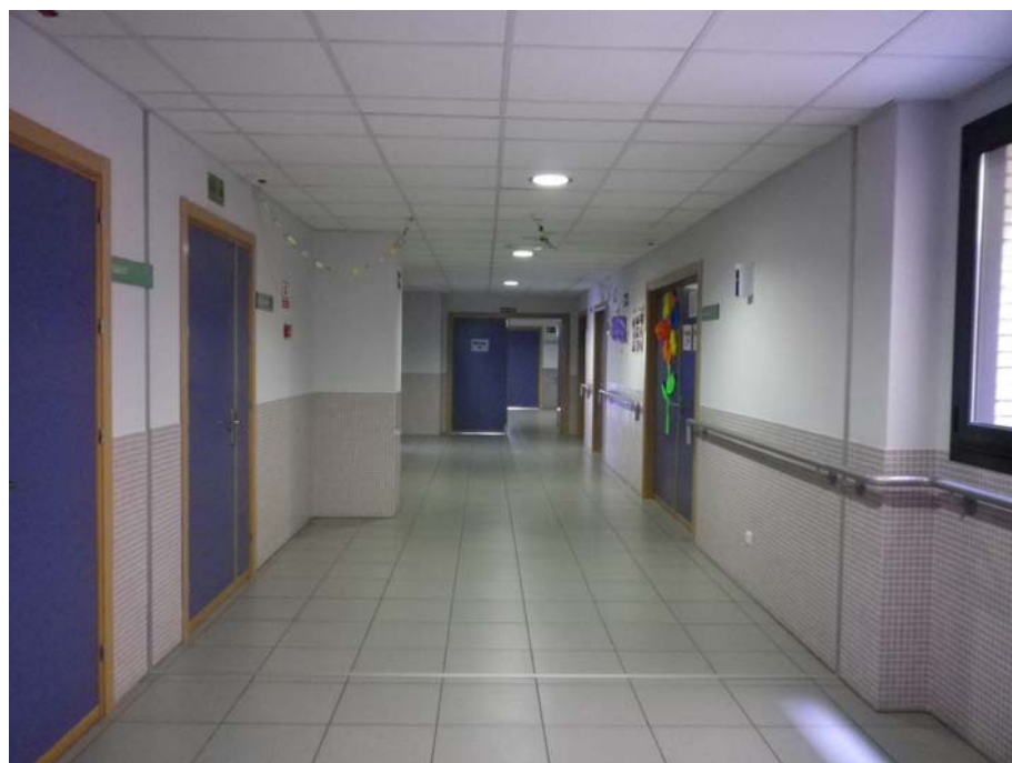
FIGURA 48 – PASILLO INTERIOR DE LA RESIDENCIA POLIVALENTE VALENTIN PALACIOS FUENTE: FOTO DE AUTOR
