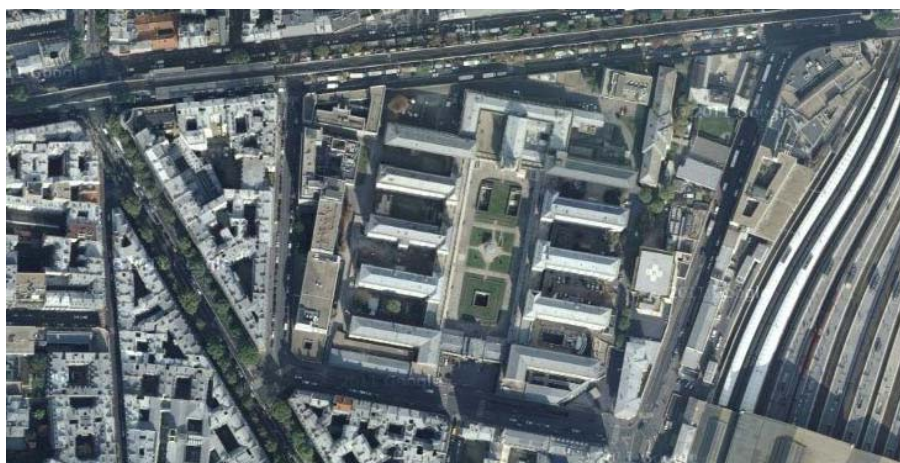
FIGURA 9 – FOTO AEREA DEL HOSPITAL LARIBOISIÈRE EN PARÍS (AÑO 2012) FUENTE: http://maps.google.es/
