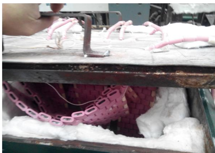
Fig. 53 – Pormenor do interior do forno.
