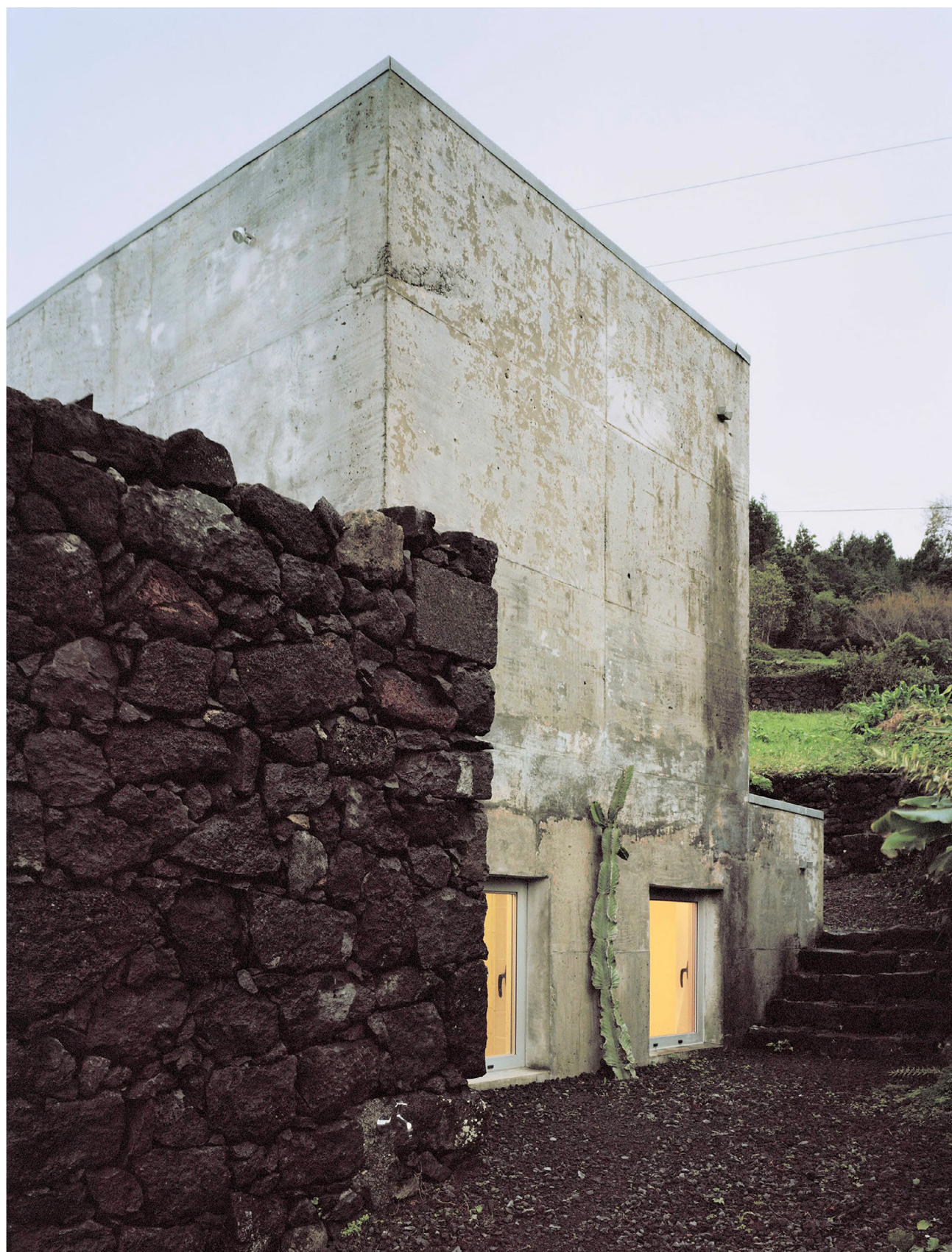
Fig.27 Edificação a partir da ruína.
