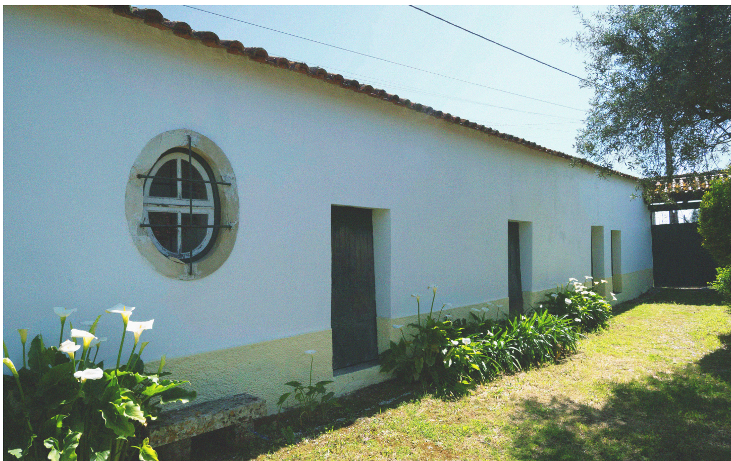
Fig.19 e 20 Jardim interior aos vários edifícios da Casa de Paredes, na frente Sul.
