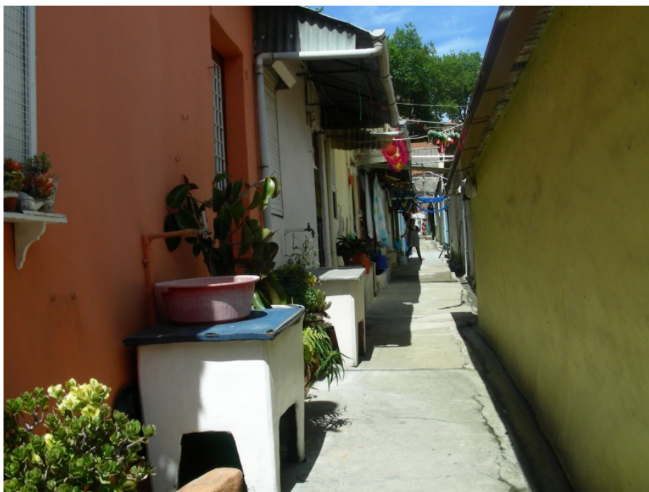
Fig. | 253 | Colocación de lavaderos en fachada
