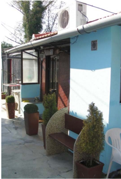
Fig. | 249 | Travessa da Póvoa, 212.
