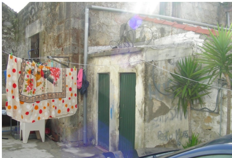
Fig. | 180 | Instalaciones sanitarias en la mitad de la "ilha"
