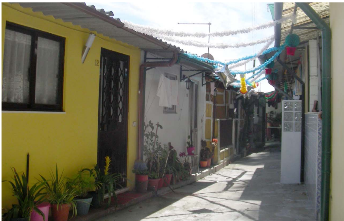
Fig. | 244 | Fachadas con acabado de diferentes materiales.
