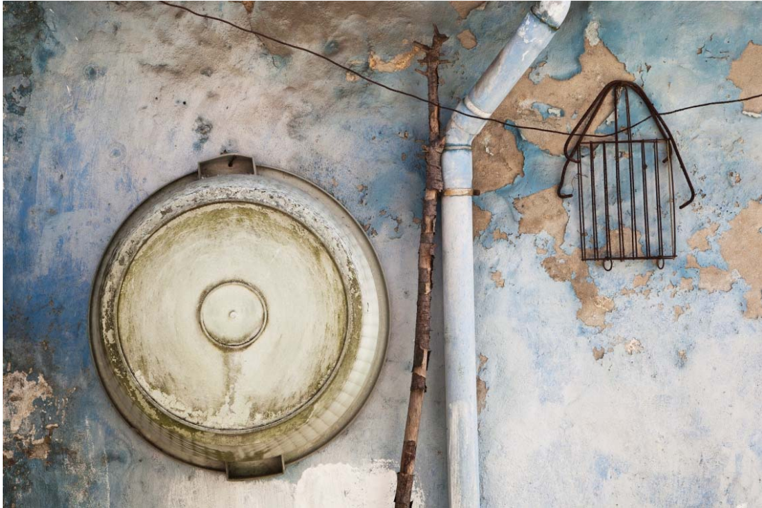
Fig. | 89 | Elementos colgados en fachada.
