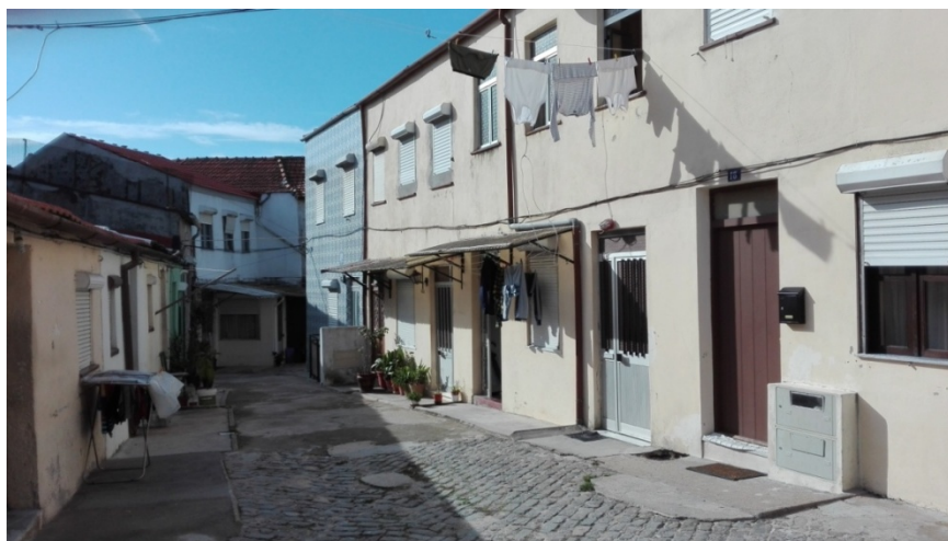
Fig. | 184 | Fachada de las edificaciones más recientes de la "ilha".
