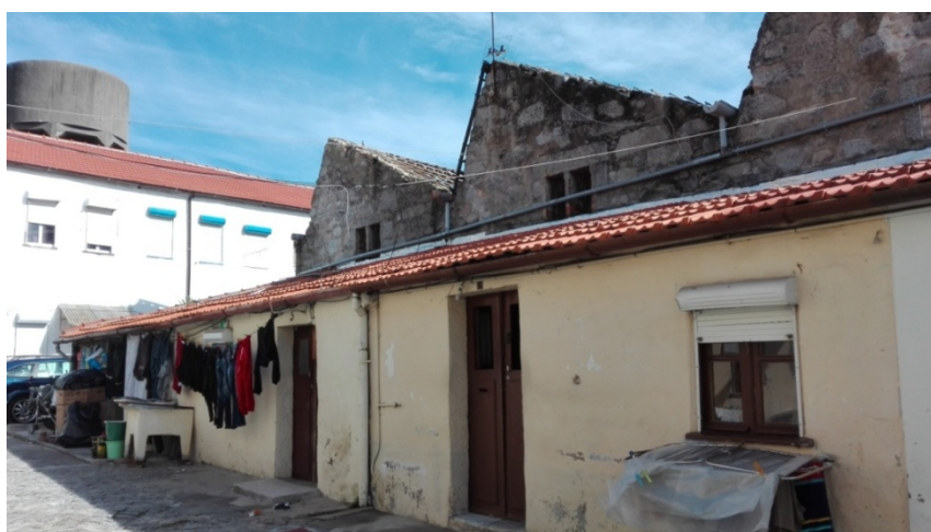
Fig. | 183 | Fachada de las viviendas más antiguas de la "ilha"
