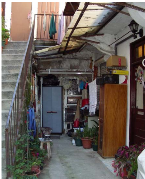
Fig. | 137 | Acceso a la vivienda del final del bloque derecho.
