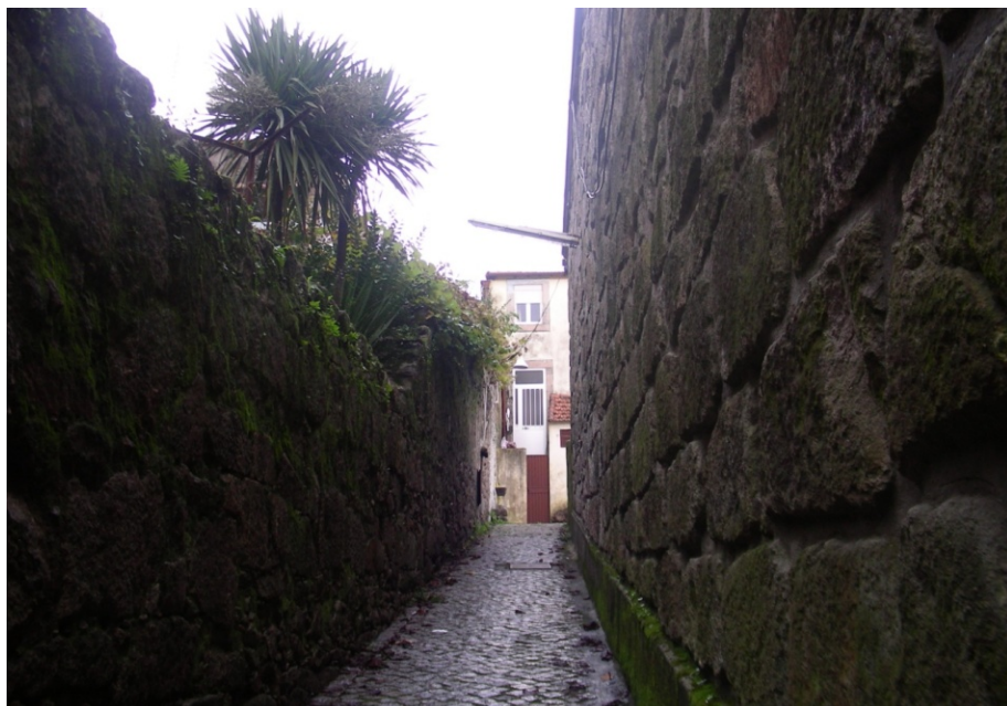
Fig. | 79 | Corredor de acceso a la "ilha".
