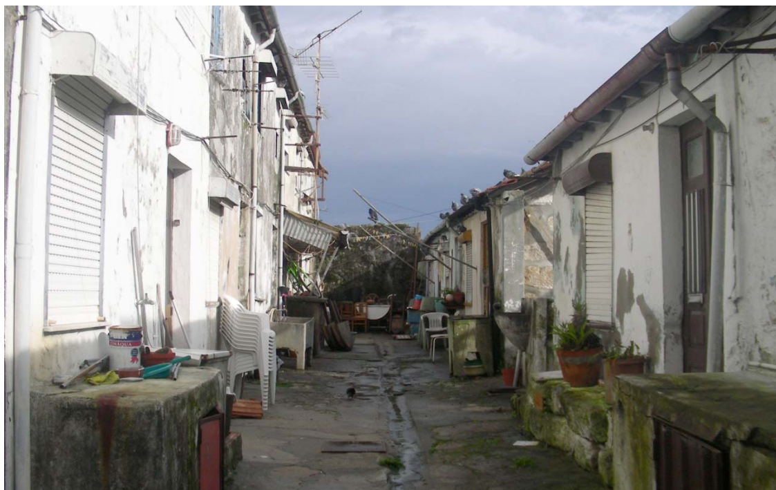
Fig. | 85 | Segundo corredor de acceso a las viviendas.
