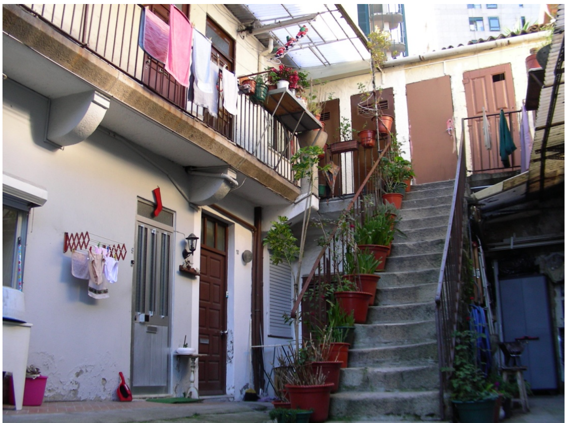
Fig. | 126 | Vista desde el patio, se visualizan los baños que unen los bloques de viviendas.
