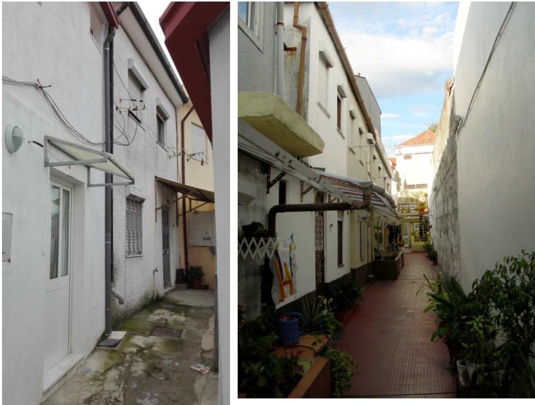
Fig. | 63 | | 64 | Travessa Fernão de Magalhães, 77. y Rúa de S. Victor , 166.
