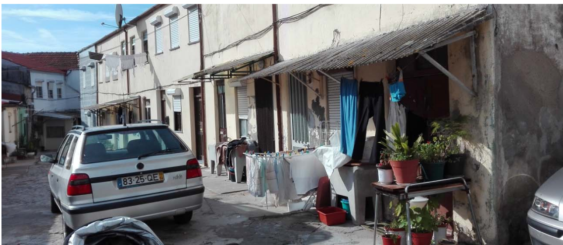
Fig. | 229 | Fachada de la vivienda. Tipología vivienda en altura.
