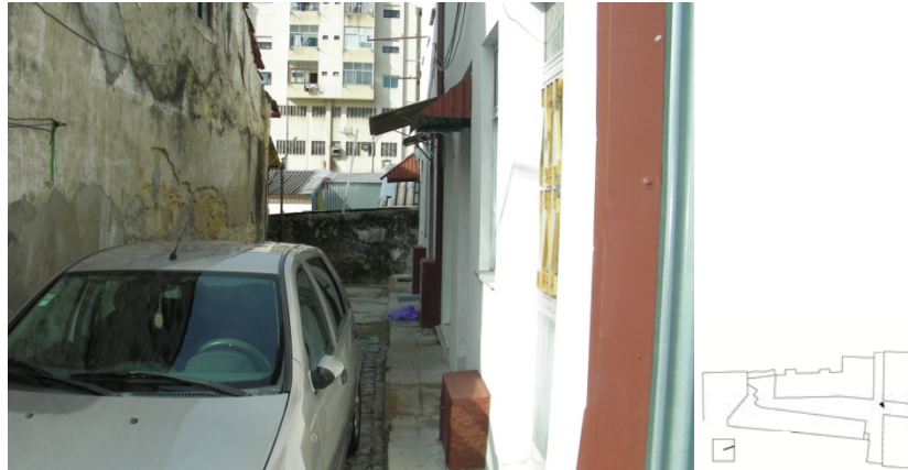
Fig. | 177 | Vista de la vía o brazo en "T"
