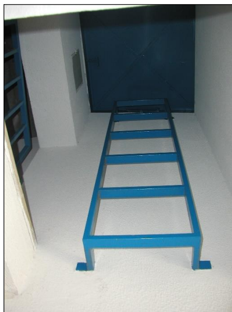
Figura 93 - Acesso à cobertura - depois da intervenção (Fonte: Autor)
