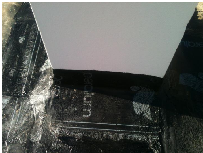
Figura 26 - Tela de impermeabilização substituída (Fonte: Autor)
