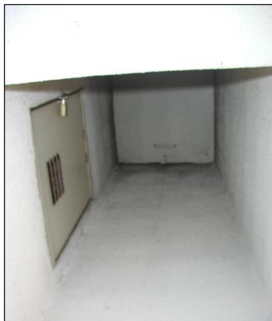
Figura 60 – Aspeto anterior do acesso à cobertura (Fonte: Autor)
