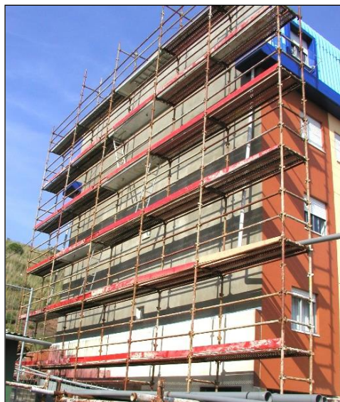
Figura 79 - Regularização da superfície da empena (Fonte: Autor)
