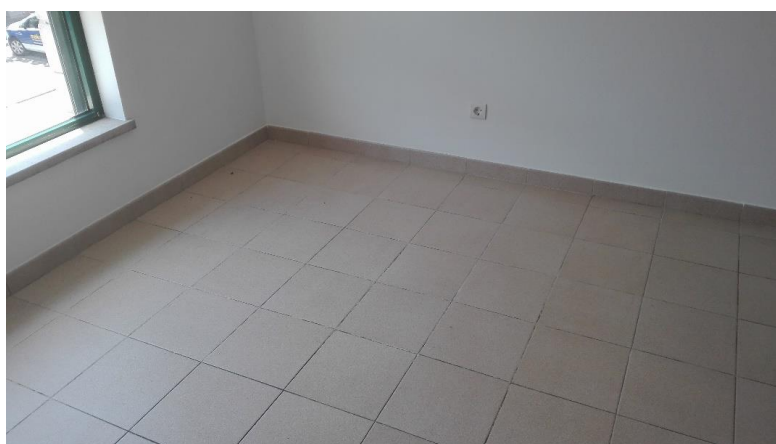
Figura 46 - Reparação de humidades devido a infiltrações do exterior (Fonte: Autor)
