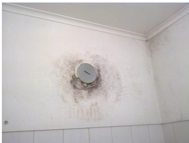
Figura 47 - Reparação de humidades em IS devido a entupimento de esgotos (Fonte: Autor)
