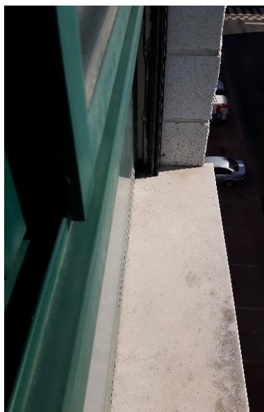
Figura 41 – Pormenor de caixilharia reabilitada (Fonte: Autor)
