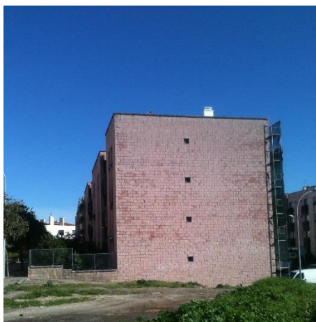
Figura 32 – Chaminé reabilitada (Fonte: Autor)
