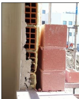
Figura 6 - Parede exterior (dupla) (Fonte: Autor)
