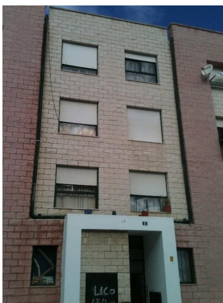
Figura 29 - Reabilitação de tubos de queda (Fonte: Autor)
