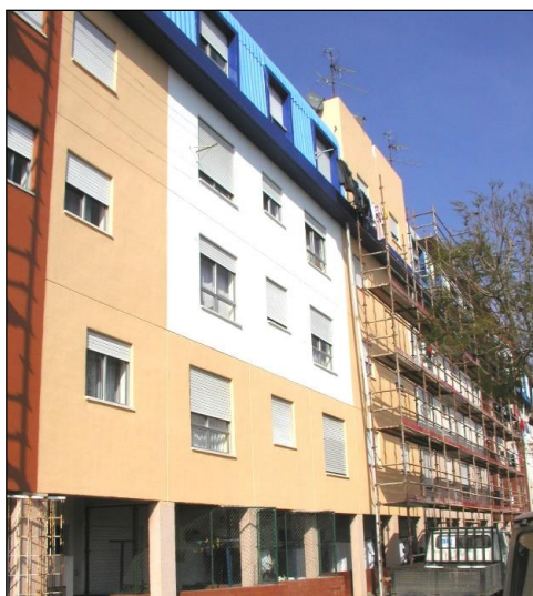
Figura 85 - Fachada pintada (Fonte: Autor)
