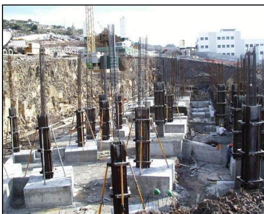
Figura 3 – Sapatas – armaduras e cofragem de pilares (Fonte: Autor)
