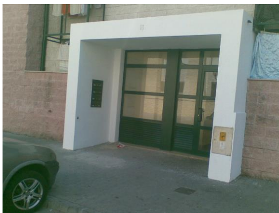
Figura 37 – Corpo de entrada reparado (Fonte: Autor)
