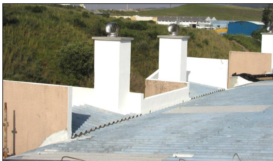
Figura 91 - Chaminés e ventiladores eólicos (Fonte: Autor)
