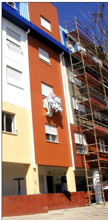
Figura 88 – Ladrilhos assentes (Fonte: Autor)
