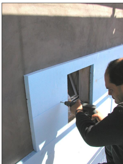
Figura 81 – Fixação das placas de poliestireno (Fonte: Autor)
