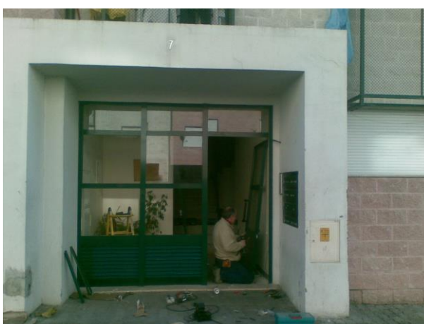
Figura 43 – Colocação de estrutura de caixilharia nova em porta de prédio (Fonte: Autor)
