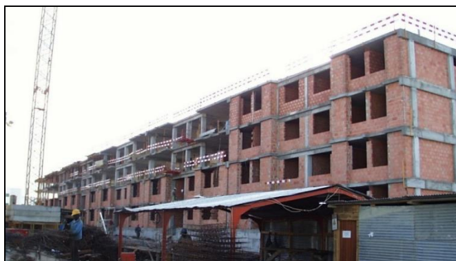
Figura 7 - Assentamento de alvenarias (Fonte: Autor)
