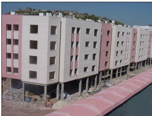
Figura 10 - Edifícios na fase de acabamento de blocos "Split" (Fonte: Autor)
