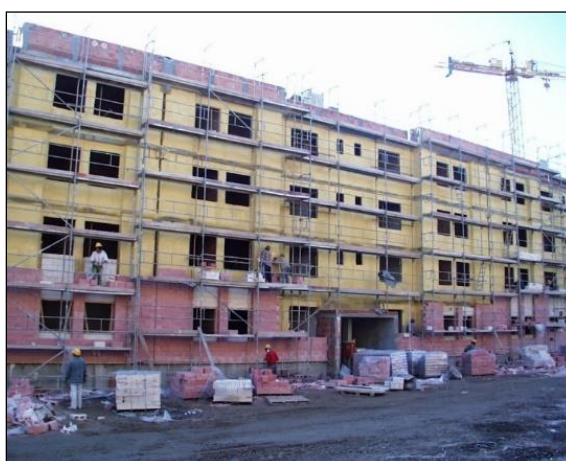
Figura 9 - Assentamento de blocos "Split" (Fonte: Autor)
