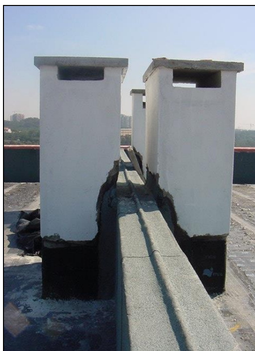
Figura 15 – Chaminés (Fonte: Autor)
