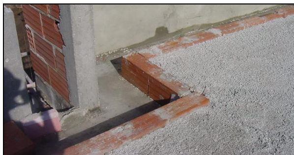
Figura 13 - Camada de forma e caleira de escoamento de água (Fonte: Autor)
