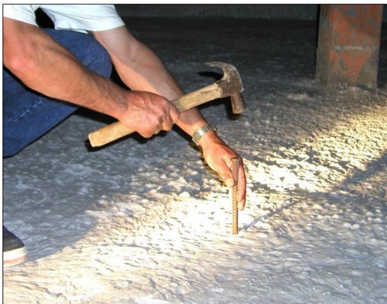
Figura 76 – Isolamento térmico da cobertura (verificação da altura) (Fonte: Autor)
