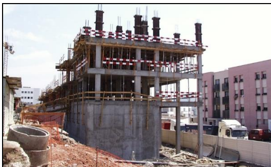
Figura 4 – Super estrutura e muro de contenção a céu aberto (Fonte: Autor)
