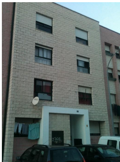
Figura 35 - Fachada de bloco "Split" reabilitada (Fonte: Autor)
