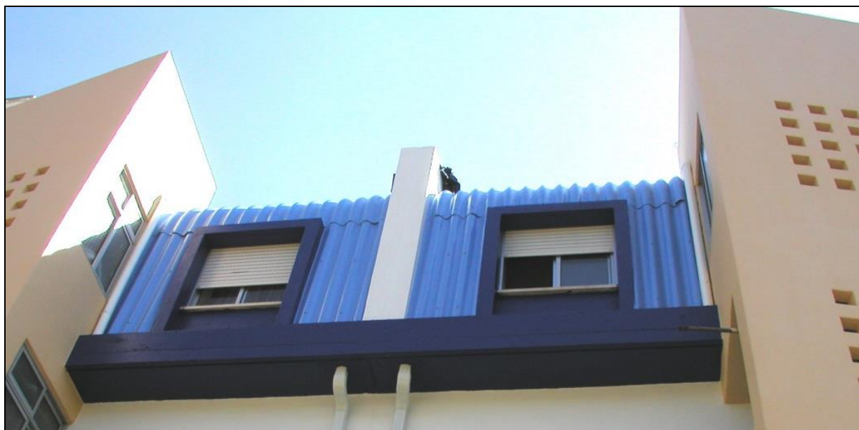
Figura 86 - Superfícies de betão e de fibrocimento pintadas (Fonte: Autor)
