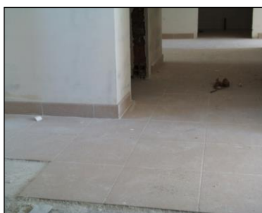
Figura 5 - Pavimento interior em ladrilho cerâmico (Fonte: Autor)
