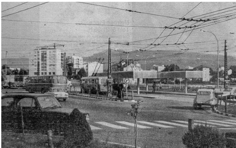
Fig. 31. Estación de Campolongo, 1975.
