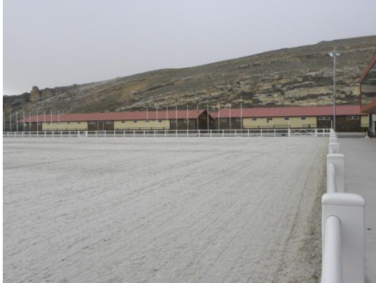
Foto 20. Pista central con boxes al fondo (CECL)
