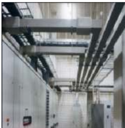
Figura 2.16: Instalação com barramento exterior (extraído de [41]).
