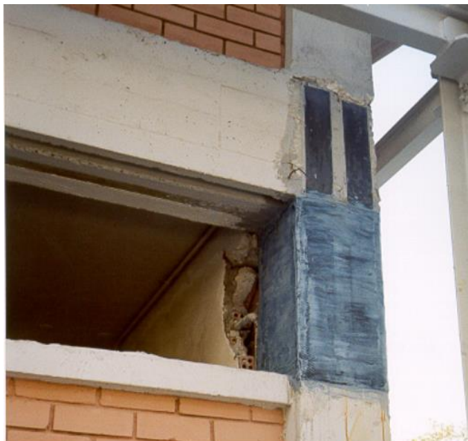
Figura 4.3.14 - Reforço transverso do pilar (fib 14.5)
