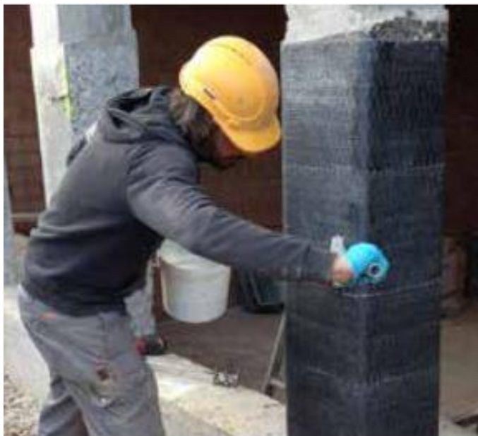
Figura 3.6.3 - Aplicação da manta pela técnica EBR (S&P C-Sheet 240)
