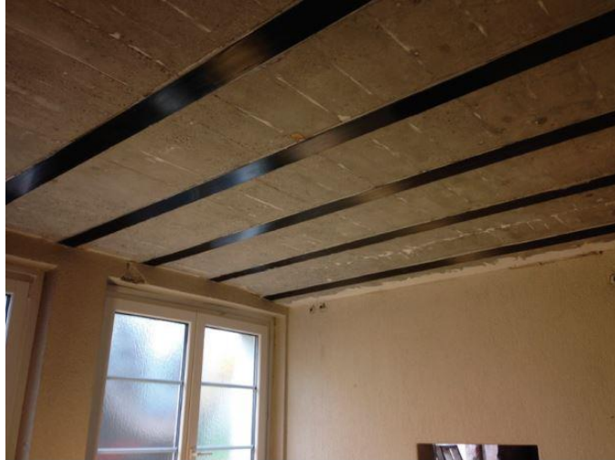
Figura 3.6.1 - Aplicação de laminados unidirecionais pela técnica EBR (S&P C-Laminate surface applied)
