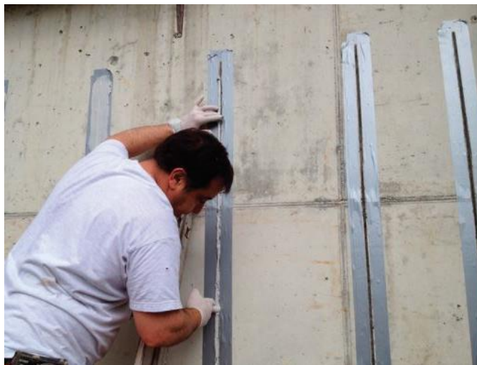
Figura 3.6.4 - Aplicação de laminados em uma parede pela técnica NSM (S&P C-Laminate (slot-applied))
