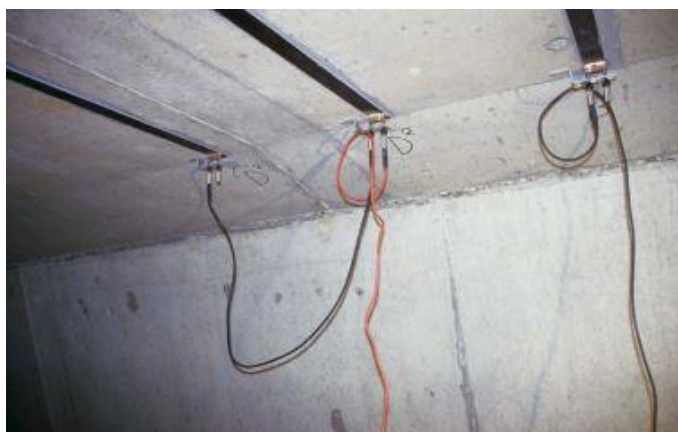
Figura 3.5.17 - Sistema de aquecimento para cura rápida na prática (fib 14.2)
