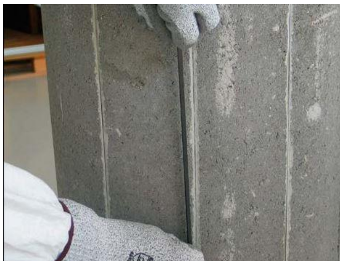
Figura 3.5.9 - Laminados num pilar pela técnica NSM (S&P C-Laminate (slot-applied))
