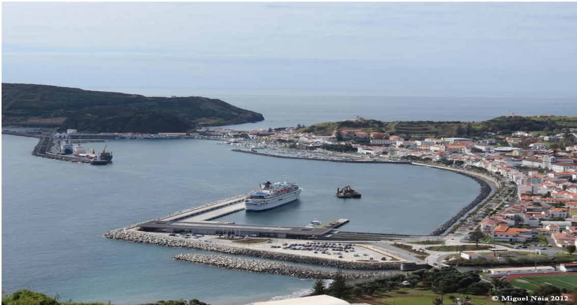
Figura 56 – Gare e terminal no Faial
