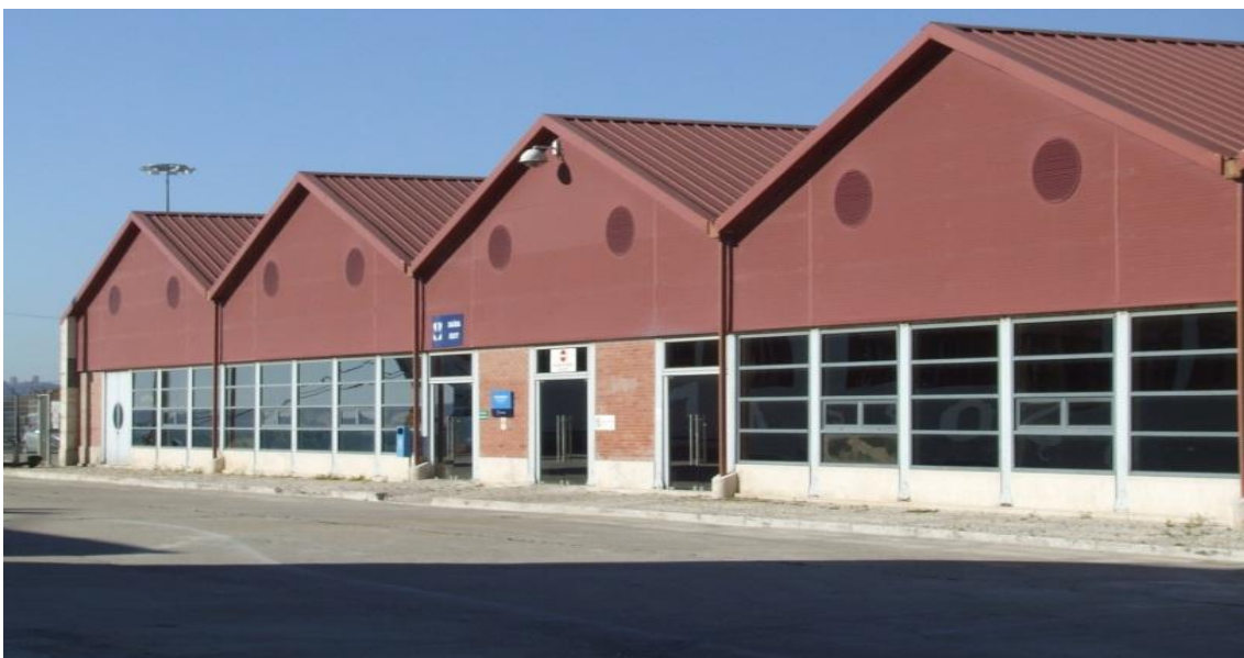
Figura 8 – Instalações do TPSA.
