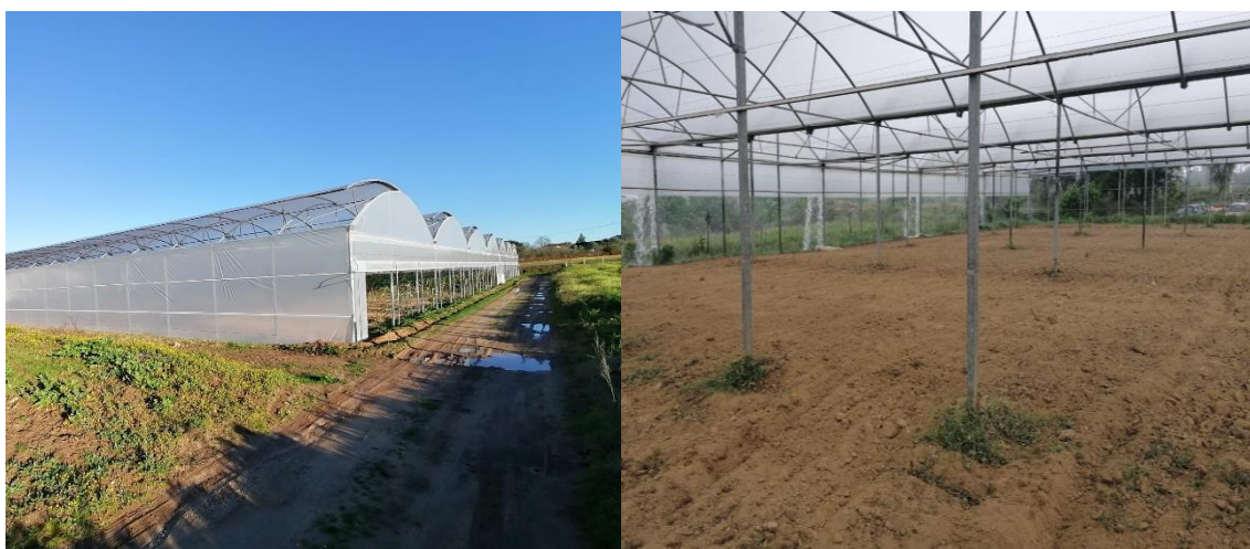
Figura 12 - Estufas metálicas de laterais retas, com 3,5m de altura à caleira e com aberturas zenitais automatizadas (Fotos do autor)
