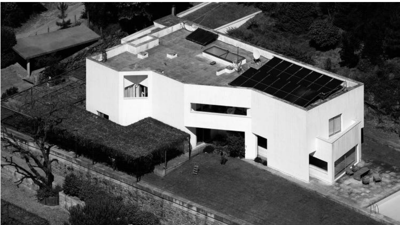
Figura 16 – Casa David Vieira de Castro, Siza Vieira
