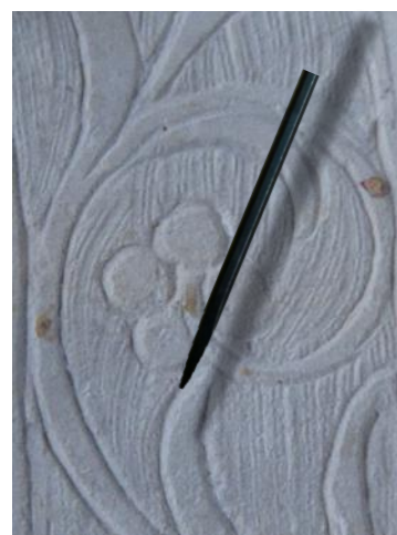
Figura 23 Detalhes ornamentais efetuados com um ponteiro fino
