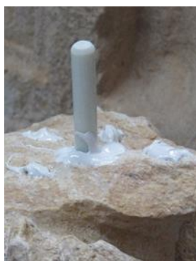
Figura 234 Aplicação de espigão e resina epóxida
