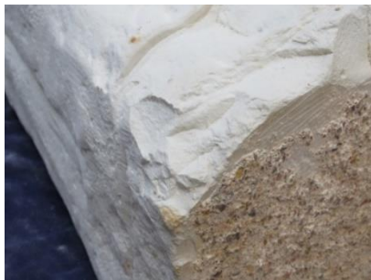
Figura 238 Argamassas na base
