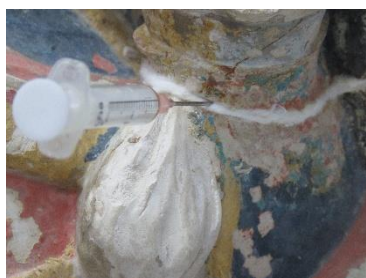
Figura 40 Aplicação do solvente com seringa
