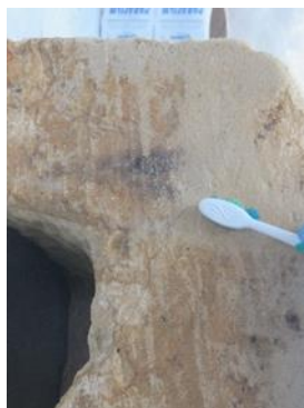
Figura 225 Limpeza dos depósitos de sujidade
