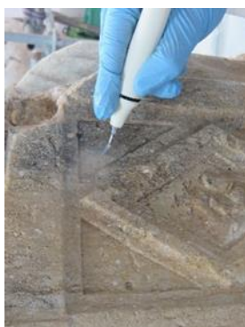
Figura 231 Remoção de manchas com ultrassons
