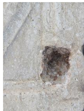
Figura 228 Limpeza das geodes
