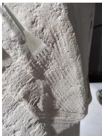
Figura 19 Suporte marcado pelo escopro dentes
