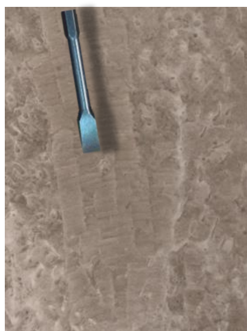
Figura 22 Desbaste efetuado com escopro liso.
