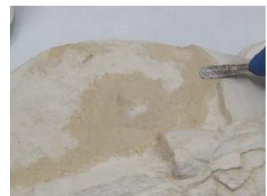
Figura 37 Preenchimentos com argamassa de cal
