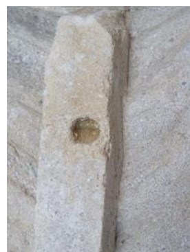
Figura 232 Limpeza de orifício
