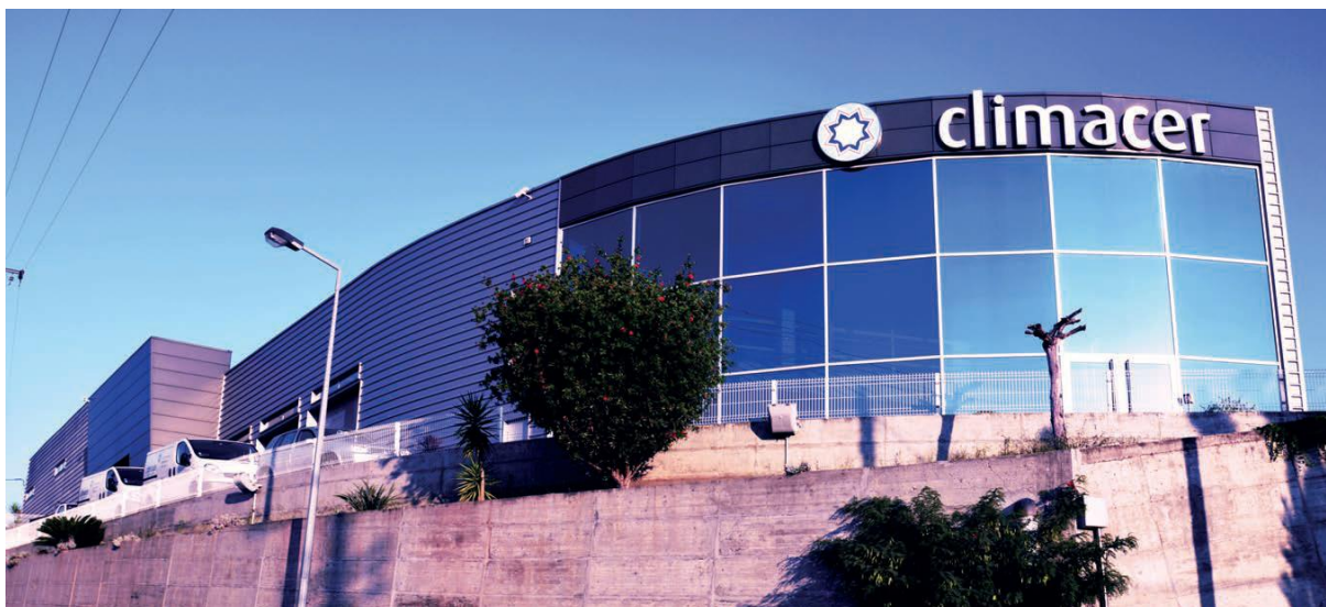
Figura 2.1. Fachada da empresa Climacer Lda. em Trouxemil
