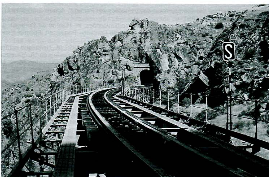
Fot. 2: Ponte de Poyo Valiente (3 tramos rectos)
