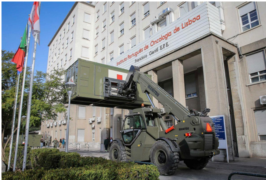
Figura 1 – Instalação do bloco cirúrgico do hospital de campanha no IPO de Lisboa
