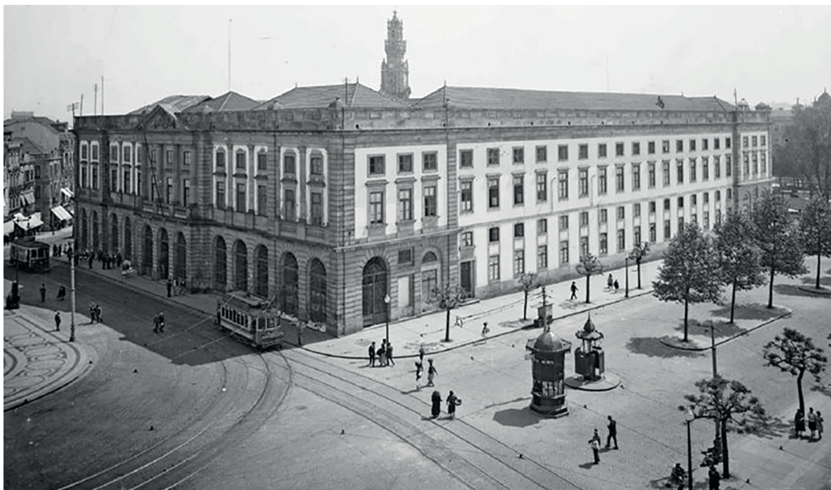
Figura 9 Edifício onde ficou instalado, inicialmente, o Computador.
