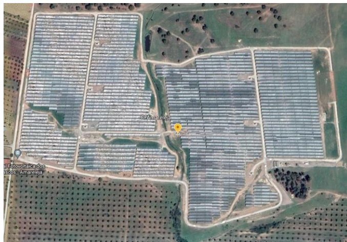
Figura 3.12 - Parque fotovoltaico CFAmareleja.
