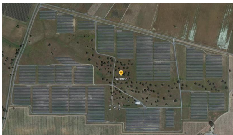
Figura 3.13 - Parque fotovoltaico FAentejo1.
