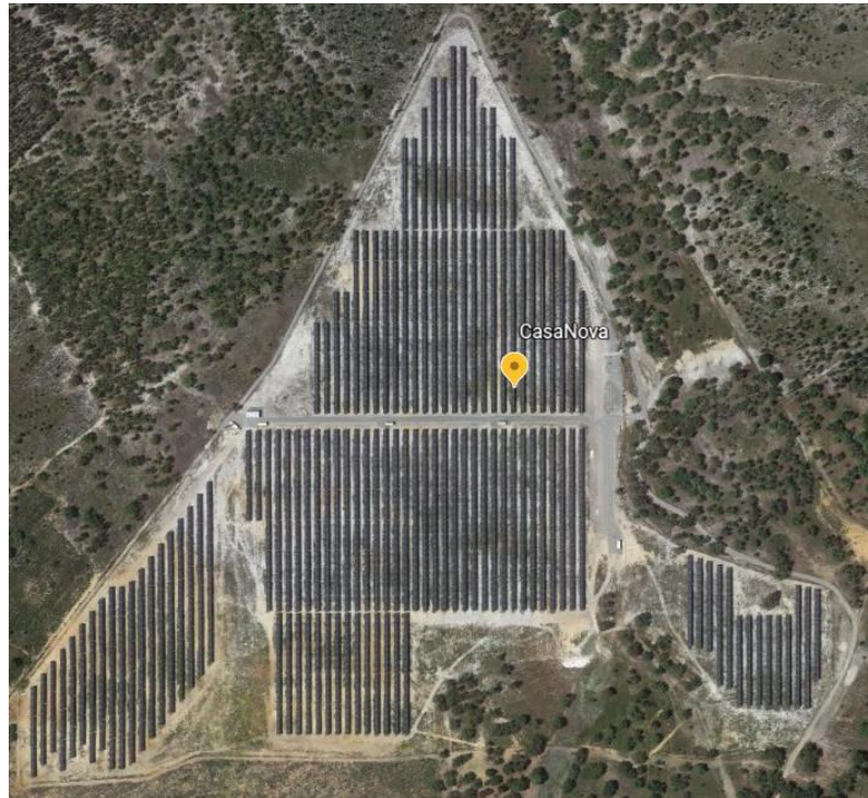
Figura 3.15 - Parque fotovoltaico CasaNova.
