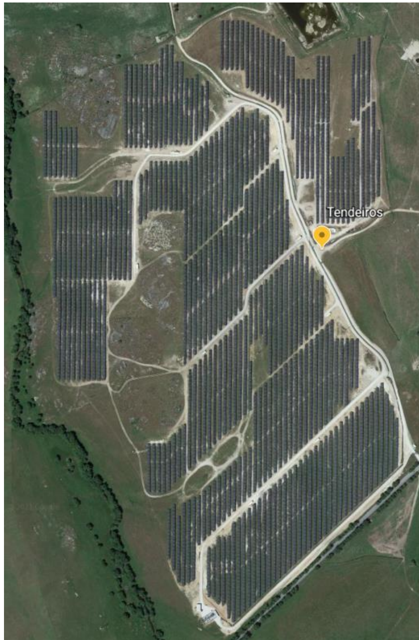
Figura 3.18 - Parque fotovoltaico Tendeiros.
