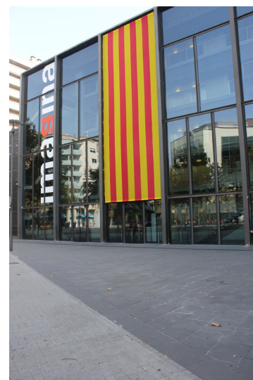
// FIGURA 02 Edifício Imagina
