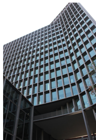
// FIGURA 01 Edifício Imagina
