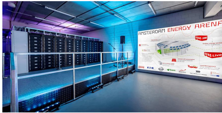
Figura 4.10. SAE com baterias de segunda vida para alimentar o estádio do Ajax em Amsterdão (Nissan, 2018).
