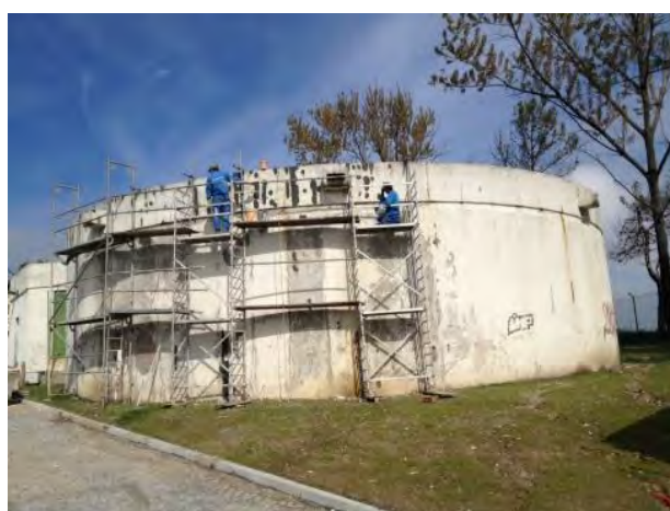
Figura 3.14 - Restauro do reservatório fissurado de S. Pedro (Vimagua, 2014)
