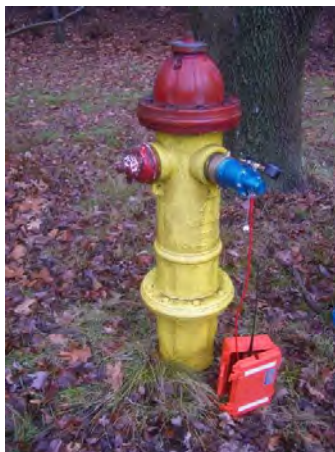
Figura 3.27 - Colocação de um hidrofone numa boca-de-incêndio (Vivax metrotech,2009)
