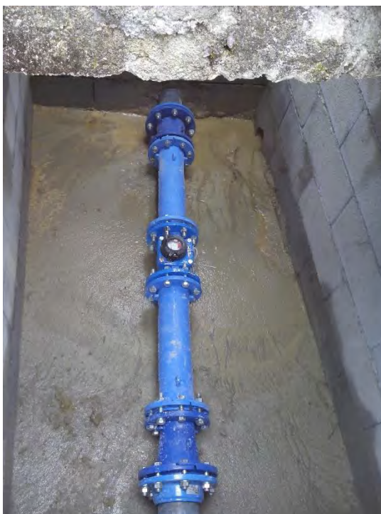
Figura 4.15 - Instalação de caudalímetro a jusante do Reservatório do Carapinhal
