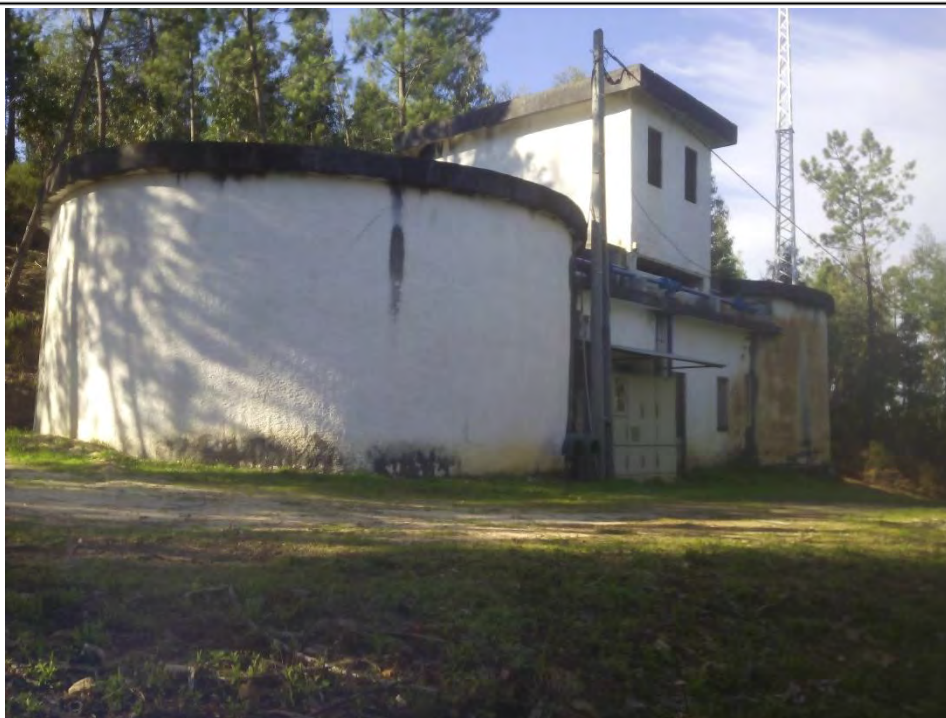
Figura 4.24 - Reservatório do Ribeiro
