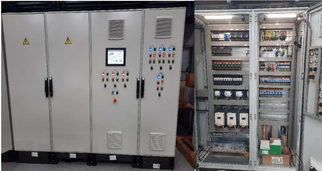
Figura 8 - Quadro para instalação de controlo e bombagem de águas.
