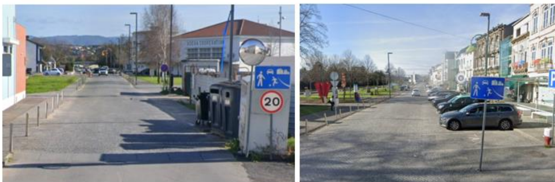
Figura 48 Vistas das entradas na zona Águeda 1 (Google Maps)
