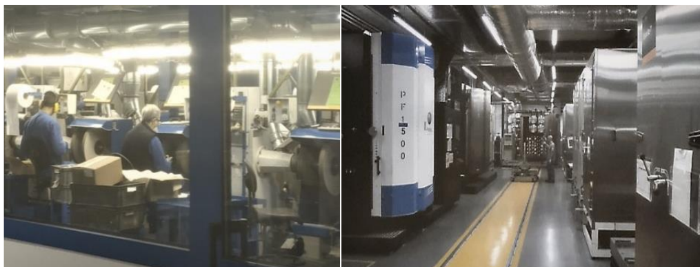
Figura 30 - Zona de brushing (à esquerda); Câmaras de PVD (à direita).
