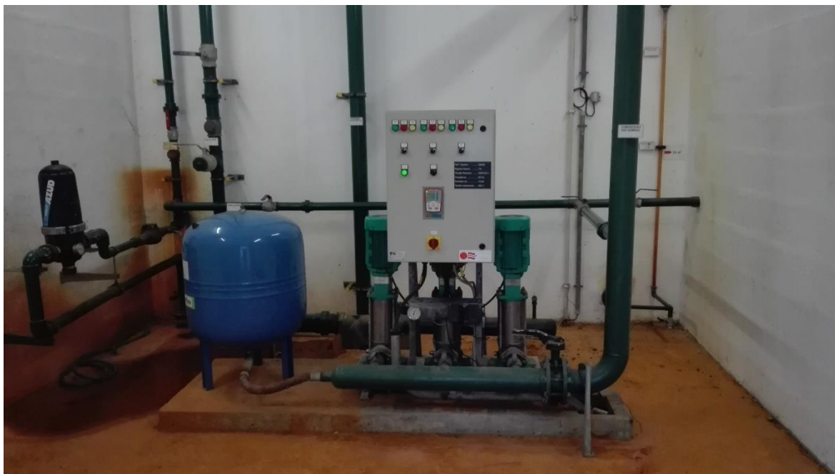
Figura 84 – Sistema de água de serviço
