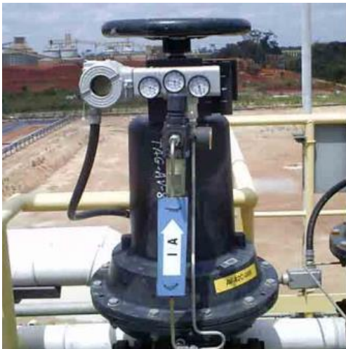
Figura 101 - – Válvula com posicionador
