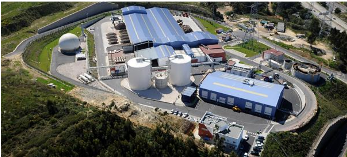
Figura 8 - Vista Aérea da ETVO
