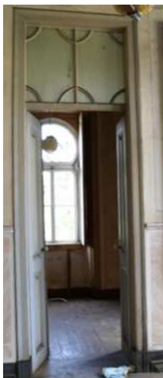
Figura 89. Caixilharia das portas interiores em madeira com bandeira rectangular e respectivo desenho.
