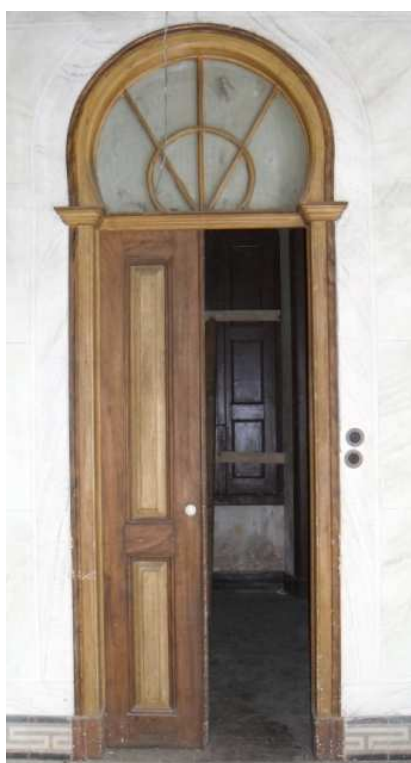
Figura 88. Caixilharia das portas interiores em madeira com bandeira redonda.
