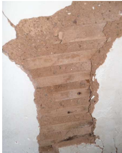
Figura 41. Paredes em tabique.
