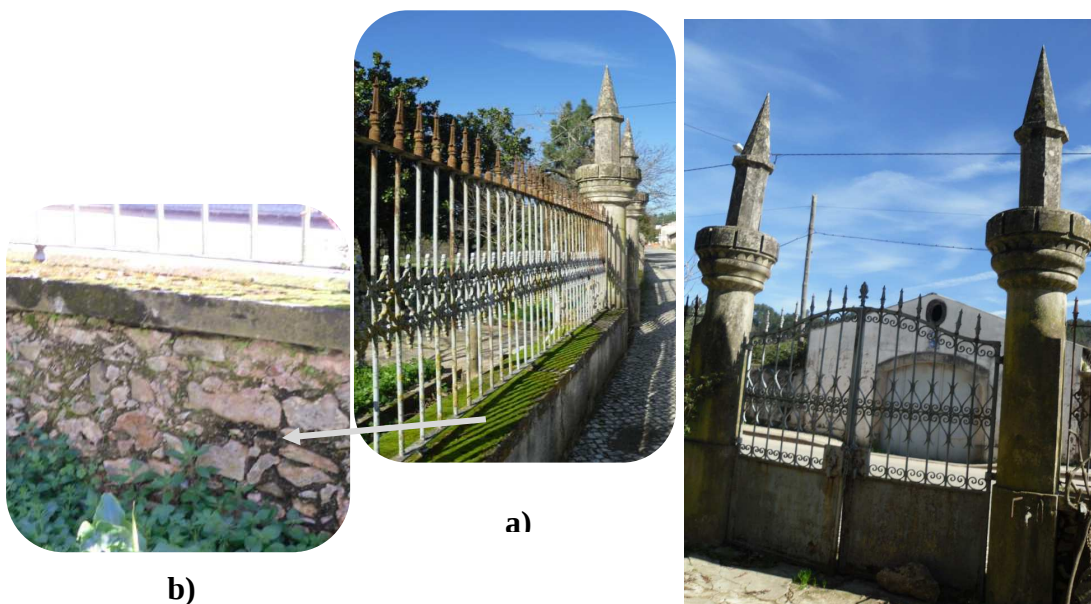
a) Pormenor do gradeamento; b) Pormenor do muro de vedação em alvenaria de pedra encimado por lajetas em pedra.
