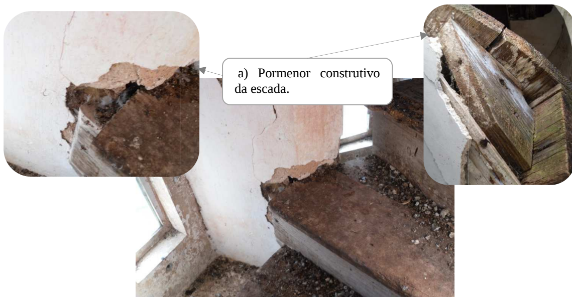
a) Pormenor construtivo da escada.
