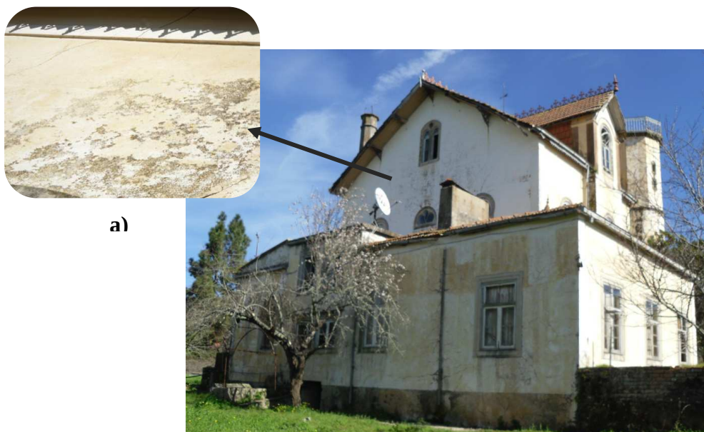
a) Pormenor do acabamento a caiado.
