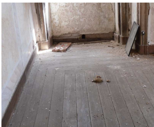
Figura 33. Pavimento encabeirado e pormenor construtivo, respectivamente.
