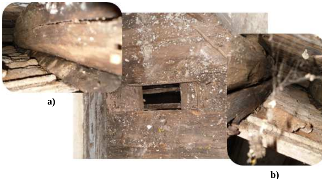
a) Pormenor da viga do pavimento em madeira; b) Pormenor da ligação das tábuas do pavimento e das ripas do tecto ao mesmo vigamento;
