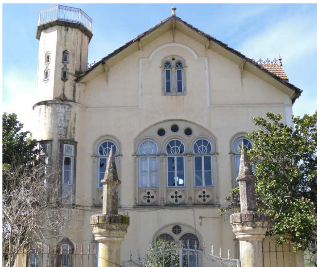
Figura 58. Cobertura inclinada de duas águas do edifício principal.
