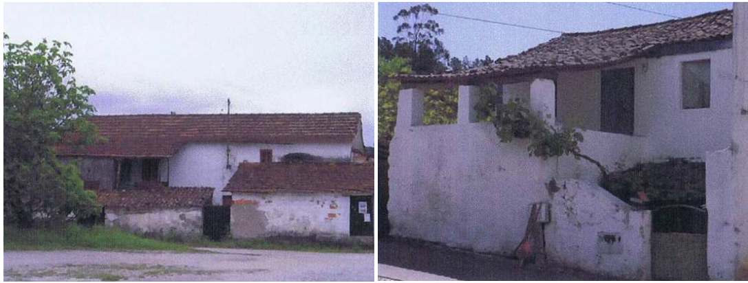
Figura 6. Edifício de habitação em Pussos e Pelmá, respectivamente (Fonte: Célia Margarida Marques).
