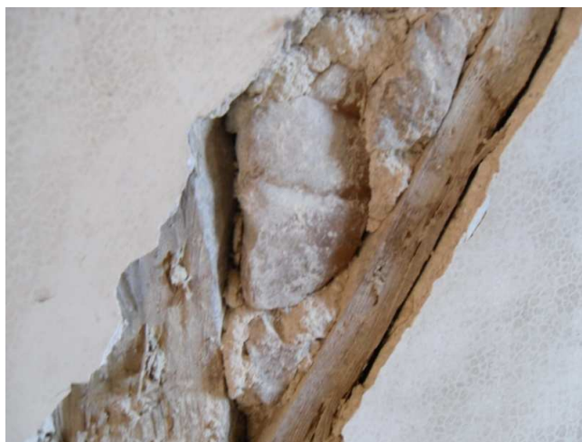
Figura 39. Parede divisória em frontal do edifício.
