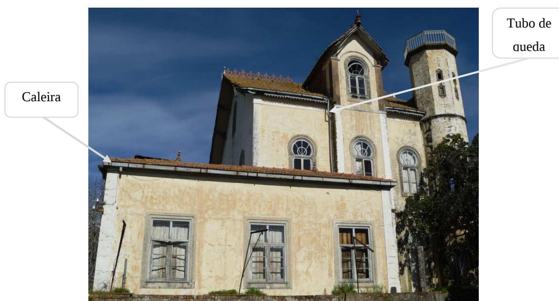
Figuras 68. Caleiras e tubos de queda em folha de zinco.
