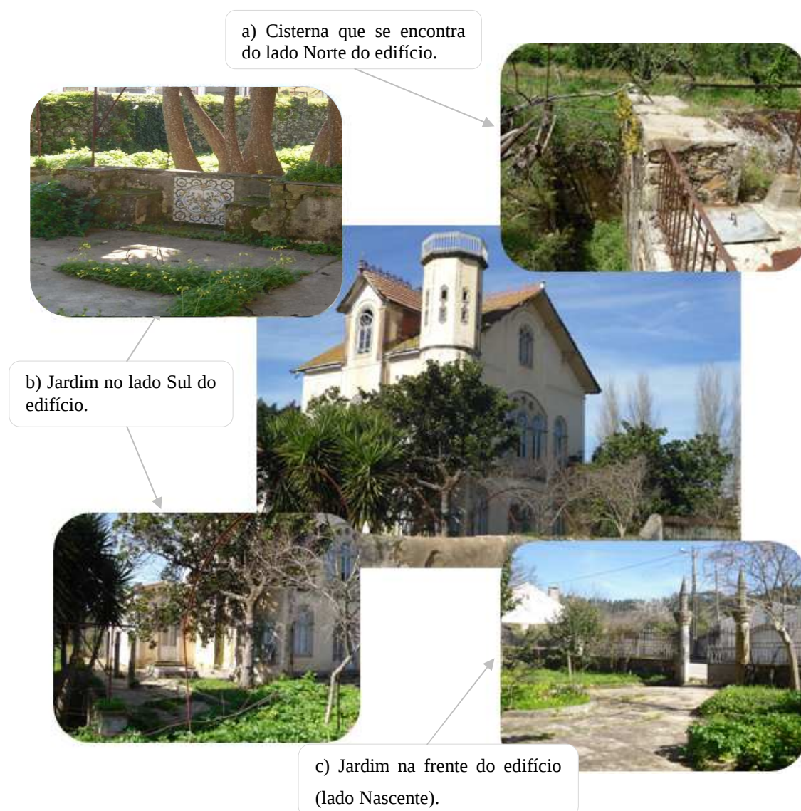
Figura 23. Vista dos jardins e cisterna do edifício.
