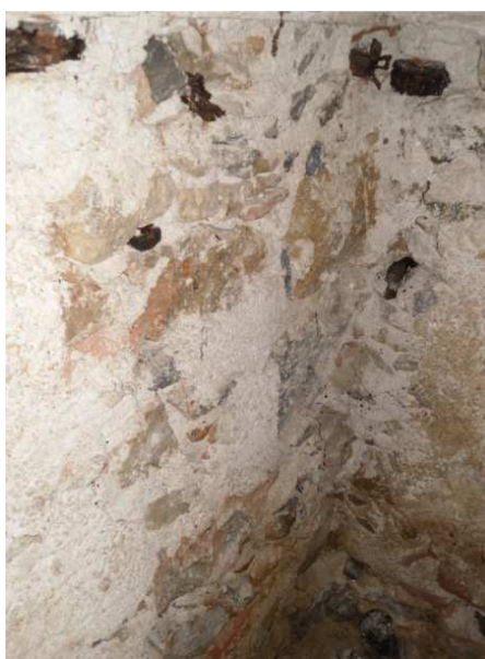
Figura 34. Parede de alvenaria exterior em pedra.
