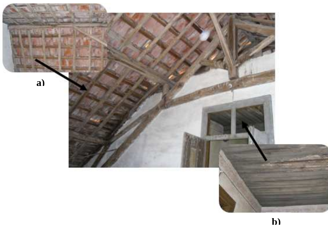
a) Forro treliçado; b) Forro horizontal.
