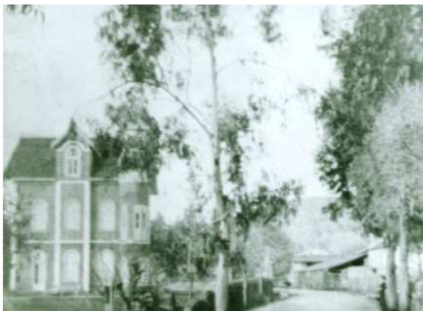
Figura 12. Fotografia do edifício principal, construído no século XIX (Fonte: Célia Margarida Marques).
