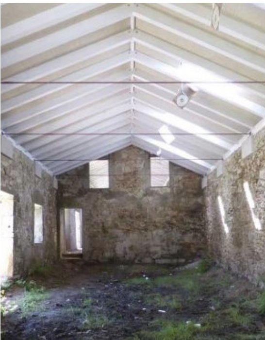
Fig. 153. Interior fábrica durante las obras
