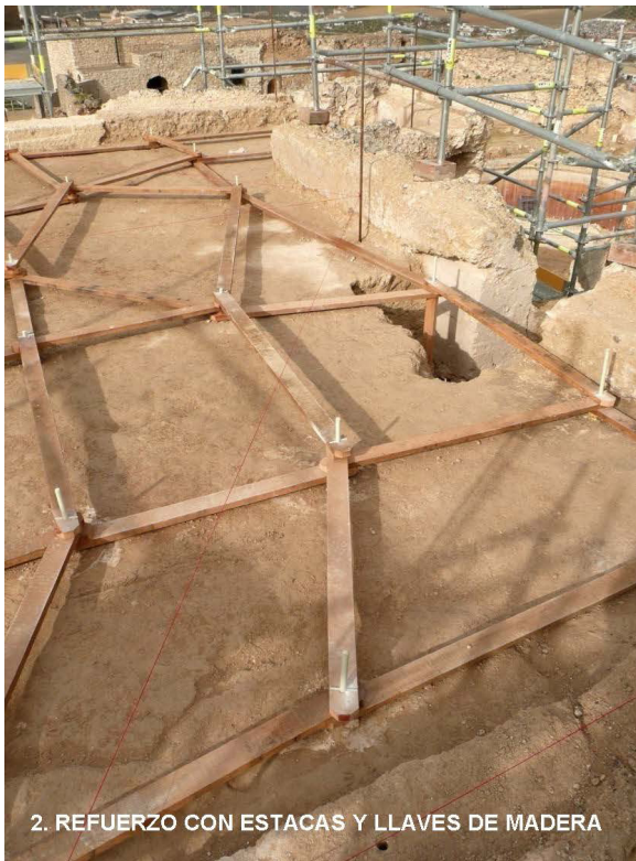
Fig. 35. Refuerzo con estacas y diferentes fases de la intervención en la Torre de los Secretos.
