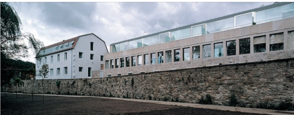
Fig. 167. Conjunto residencial Vaquería de Carmen de Abaixo después de la intervención
