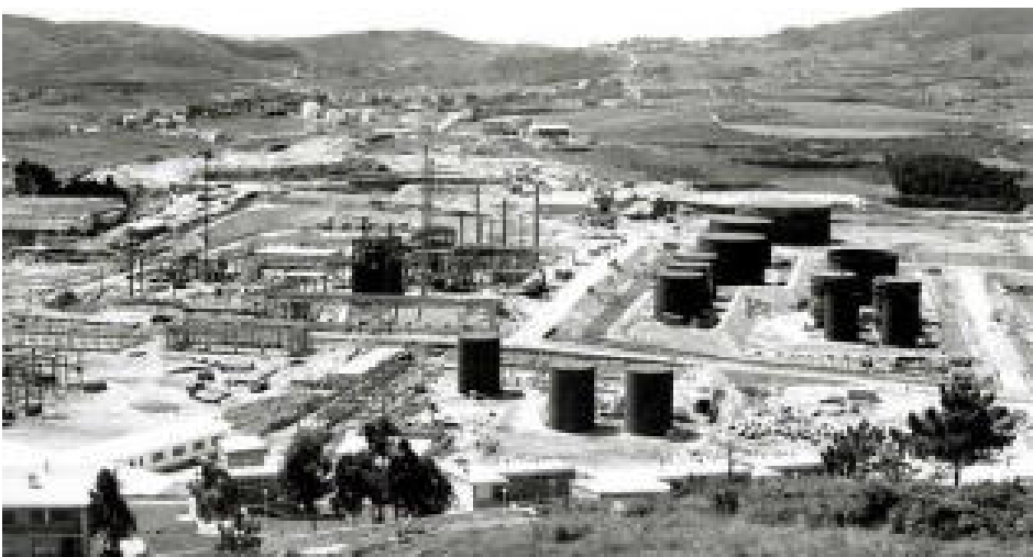
Fig. 74. Vista de la zona de Bens (La Coruña) durante el proceso de construcción de la refinería de petróleo.
