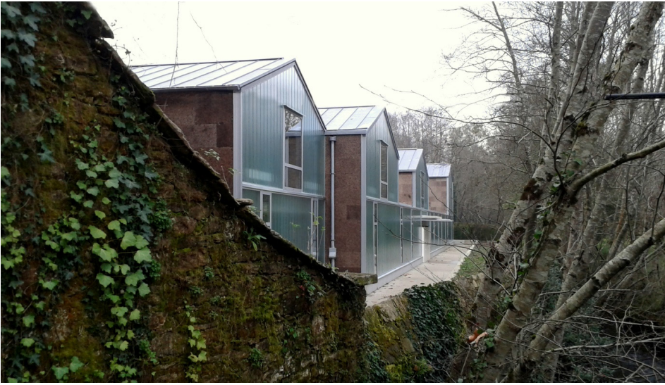
Fig. 155. Vista de las naves de nueva planta
