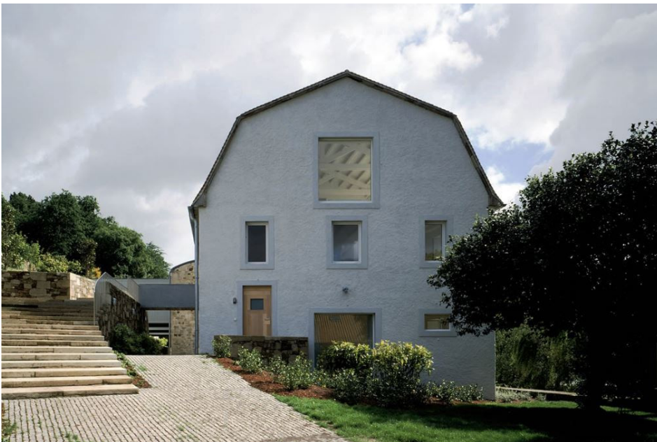
Fig. 175. Vaquería después de la intervención
