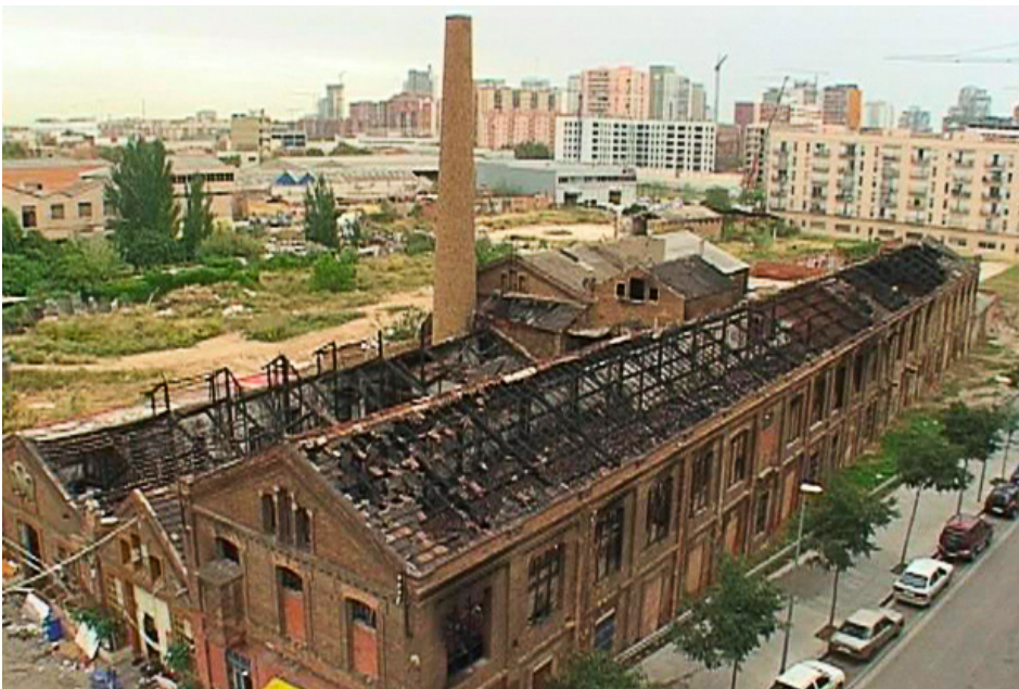
Fig. 18. Antigua fábrica de Ca l'Alíer
