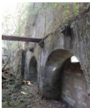
Fig. 210. Estado actual interior fábrica
