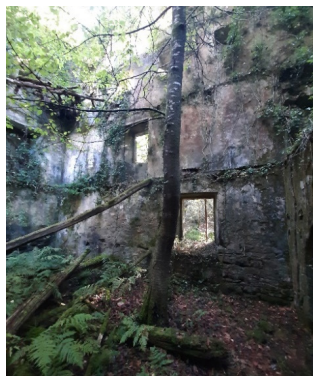
Fig. 211. Vista interior cerramiento exterior
