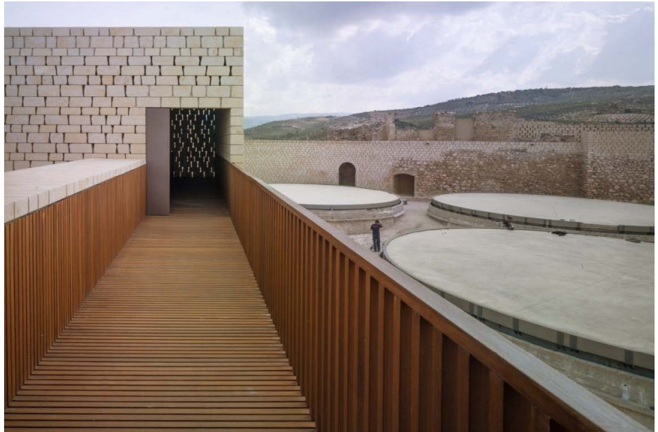
Fig. 42. Pasarela de madera que une la Torre Noroeste y la Torre de los Cascabeles
