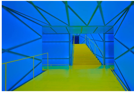
Fig. 137. Vista interior zonas de distribución
