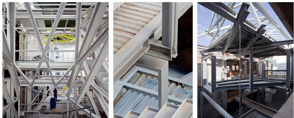
Fig. 135. Imágenes de la obra. Conjunto estructural de "La Cosa".
