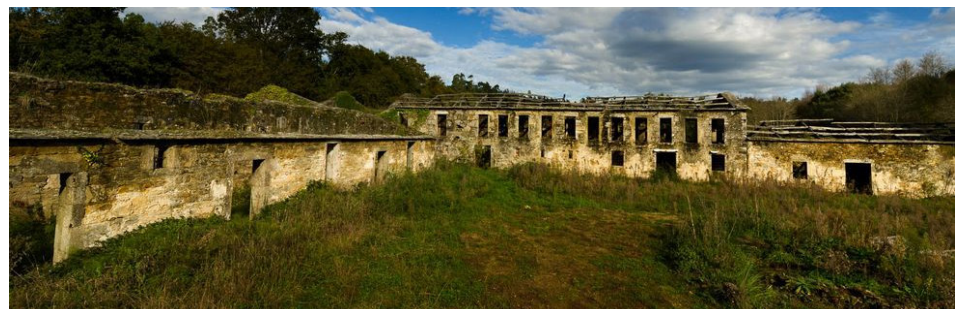
Fig. 146. Vista conjunto edificado desde el interior de la Curtidoría antes de la intervención.
