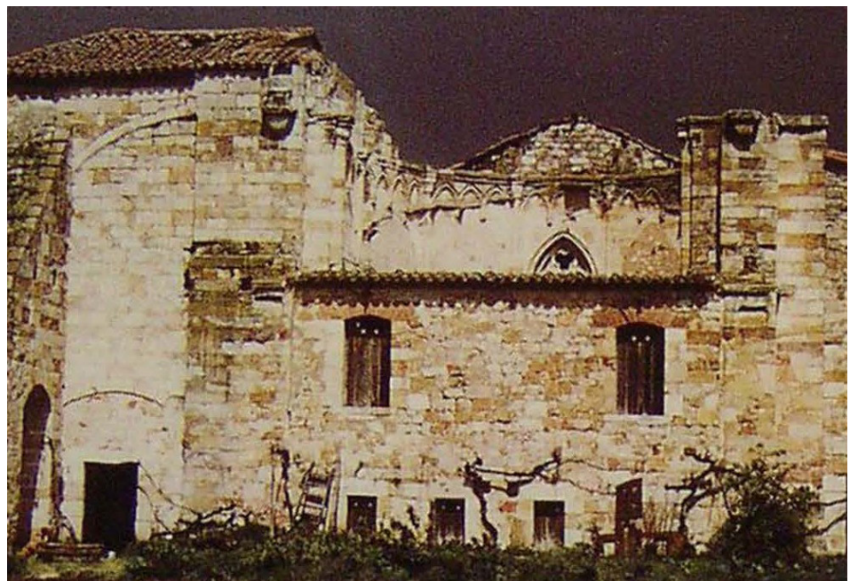
Fig. 46. Estado original de la capilla de los Ocampo y ábside.
