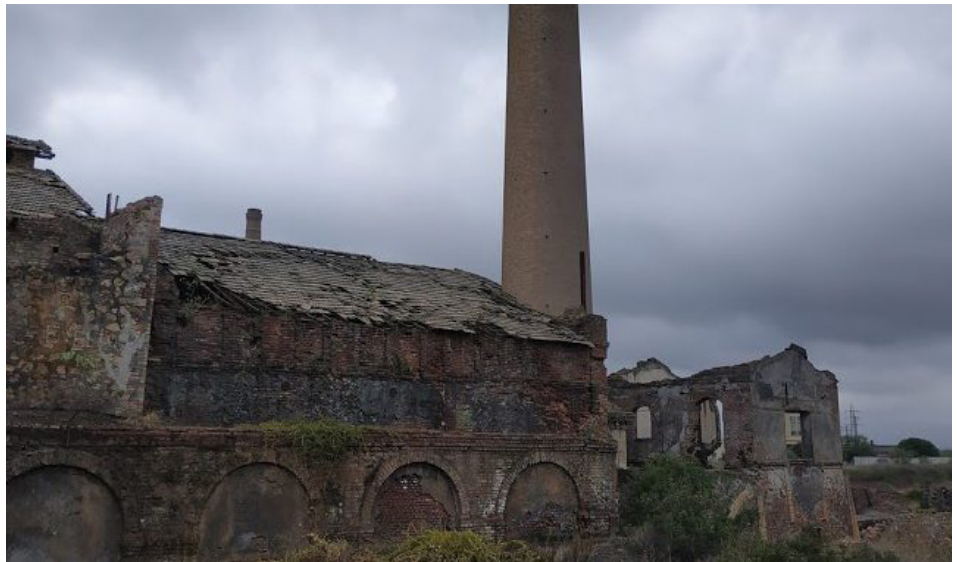
Fig. 22. Almacén Central del cerco industrial de Peñarroya (Córdoba)
