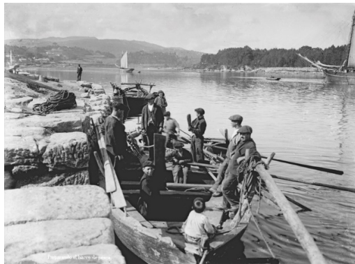
Fig. 72. Muelle de A Mooureira. Pontevedra (1900) (Pontevedra)
