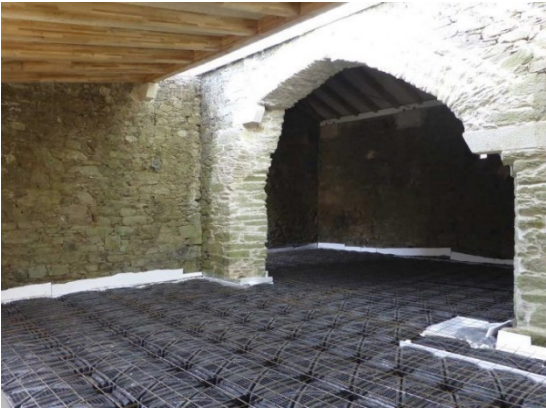
Fig. 152. Interior fábrica durante las obras.
