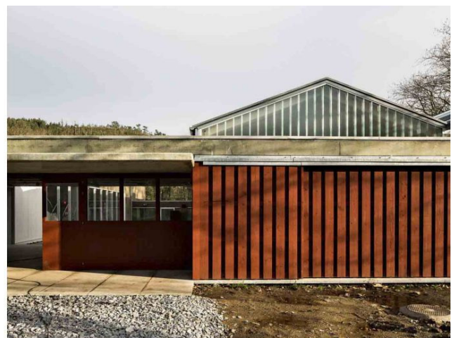
Fig. 160. Vista aérea y detalle revestimiento del nuevo Centro de Formación de la Construcción.
