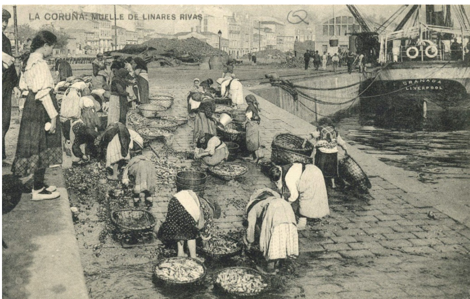
Fig. 70. Muelle de Linares Rivas. La Coruña (1900-1940)
