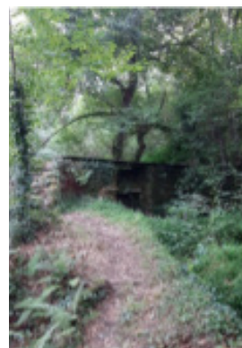
Fig. 207. Estructura porticada canal
