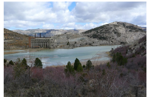
Fig. 20. Central térmica de Aliaga
