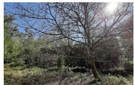
Fig. 204. Estado actual fachada Norte
