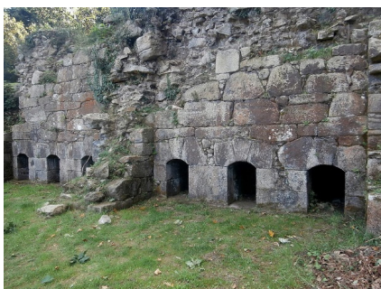
Fig. 67. Ruinas de los hornos de calcinación de mineral del complejo fabril de Sargadelos.
