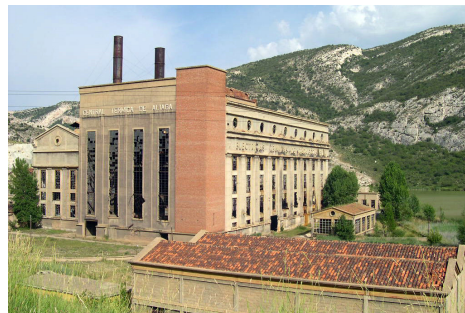
Fig. 19. Central térmica de Aliaga
