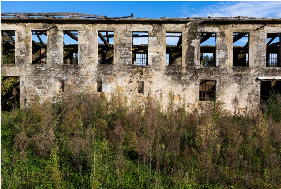
Fig. 148 Fachada de uno de los edificios antes de la intervención.
