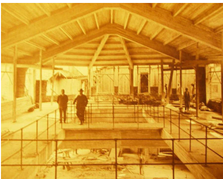
Fig. 116. Interior de la nave. Estado original
