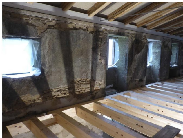
Fig. 154. Sistema estructural a base de madera laminada con ensamble de cola de milano.
