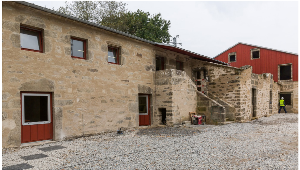
Fig. 158. Vista Centro de Formación después de la intervención
