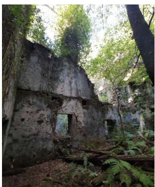
Fig. 212. Estado actual muros divisorios
