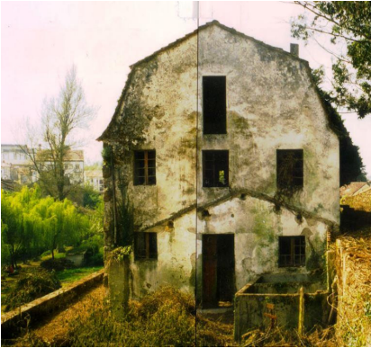
Fig. 171. Vista vaquería antes de la intervención
