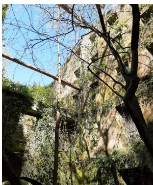
Fig. 209. Restos estructura de cubierta
