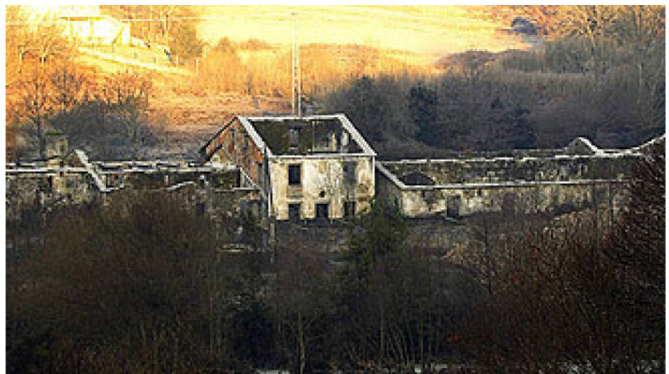
Fig. 143. Vista de la Curtidoría en estado ruinoso
