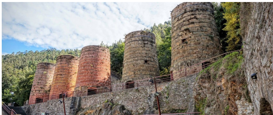
Fig. 55. Hornos de calcinación, Pontenova
