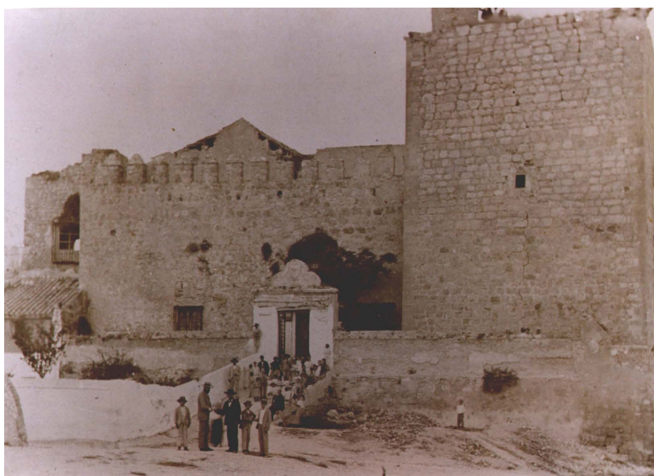
Fig. 29. Torre de las Arquerías y lienzo Oeste
