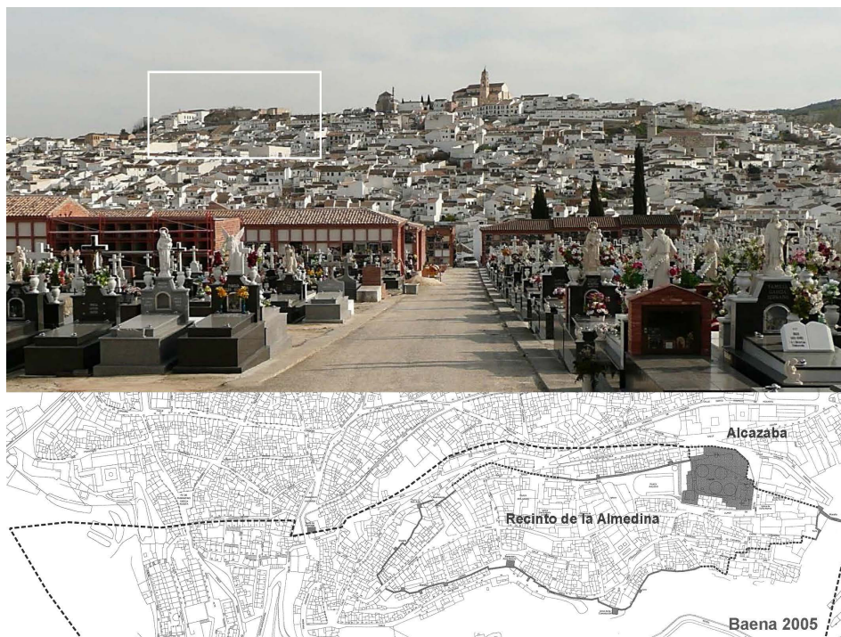
Fig. 30. Vista antes de la intervención del Castillo de Baena y plano de situación
