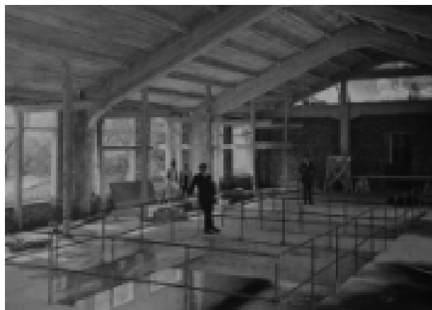
Fig. 126. Interior de la nave. Estado original
