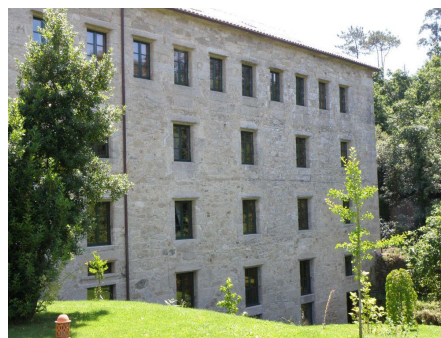
Fig. 58. Fachada de poniente (2009)
