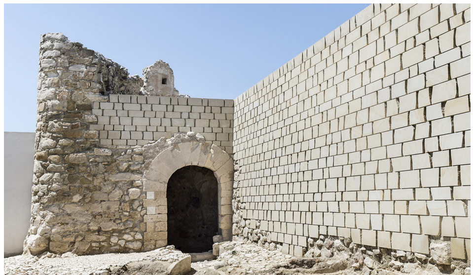
Fig. 38. Estado Final puerta de la Liza.. Torre Sur
