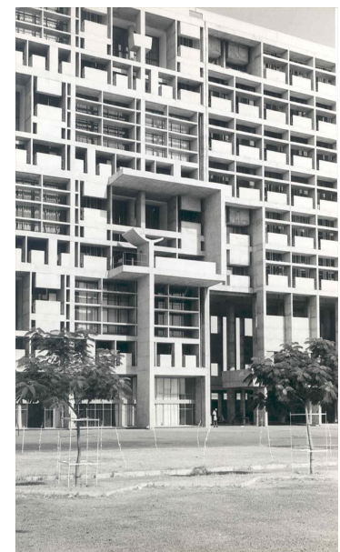
Imagem12 Secretariado, vista das varandas abertas, aplicação de brise-soleil verticais, Le Corbusier, Chandigarh, Punjab, 1953, fotografia s.d.
