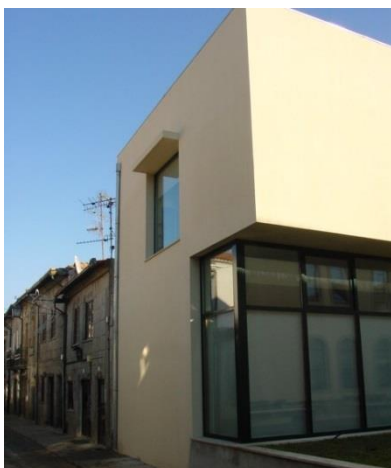
Fig. 33 Câmara Municipal vista da Rua Direita - S/ident. do autor
