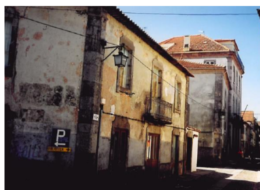
Fig. 143 Estado da pré-existência antes da intervenção Triplano (1997)
