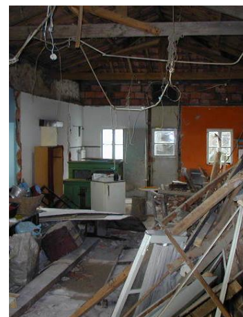
Fig. 111 Interior durante as obras Consultores (2002)
