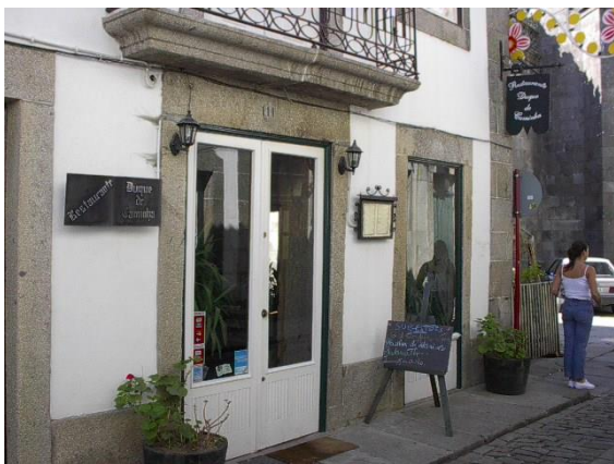
Fig.72 Exterior do edifício depois da intervenção S/ident. do autor
