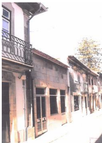
Fig.85 Alçado frontal antes da intervenção – Azero (2002)
