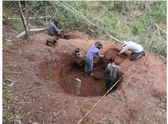
Figura 56 - Escavação sendo realizada na área do sítio.
