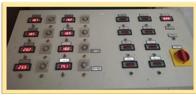
Figura 31 - Painel de controlo de remontagem e temperatura
