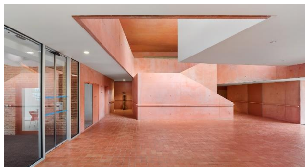
Figura 53 - Escadaria principal feita de betão armado pigmentado.
