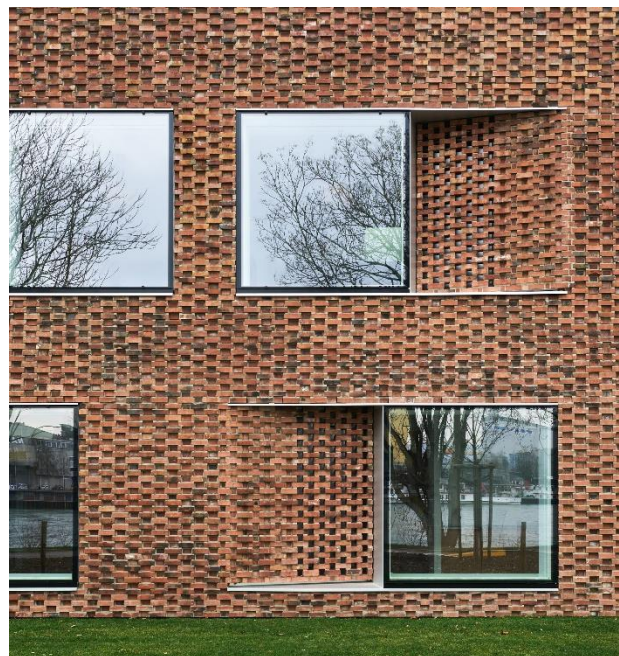
Figura 52 - É utilizado tijolo vermelho irregular e ocasionalmente deformado para revestir todas as superfícies externas do edifício.
