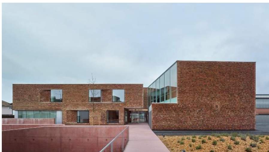
Figura 51 – Textured Brick Facades – habitação para pessoas idosas - Dominique Coulon, Huningue, França, 2018.
