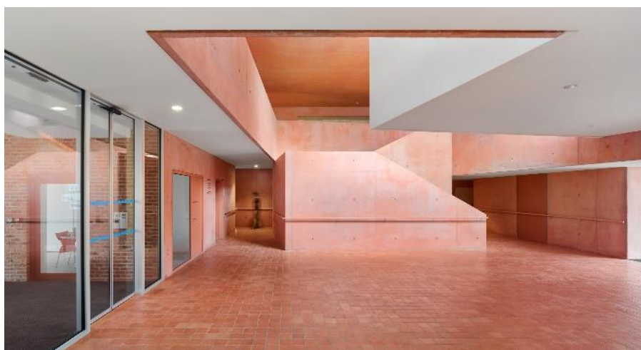
Figura 53 - Escadaria principal feita de betão armado pigmentado.
