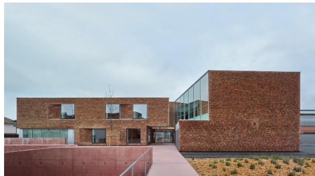
Figura 51 – Textured Brick Facades – habitação para pessoas idosas - Dominique Coulon, Huningue, França, 2018.
