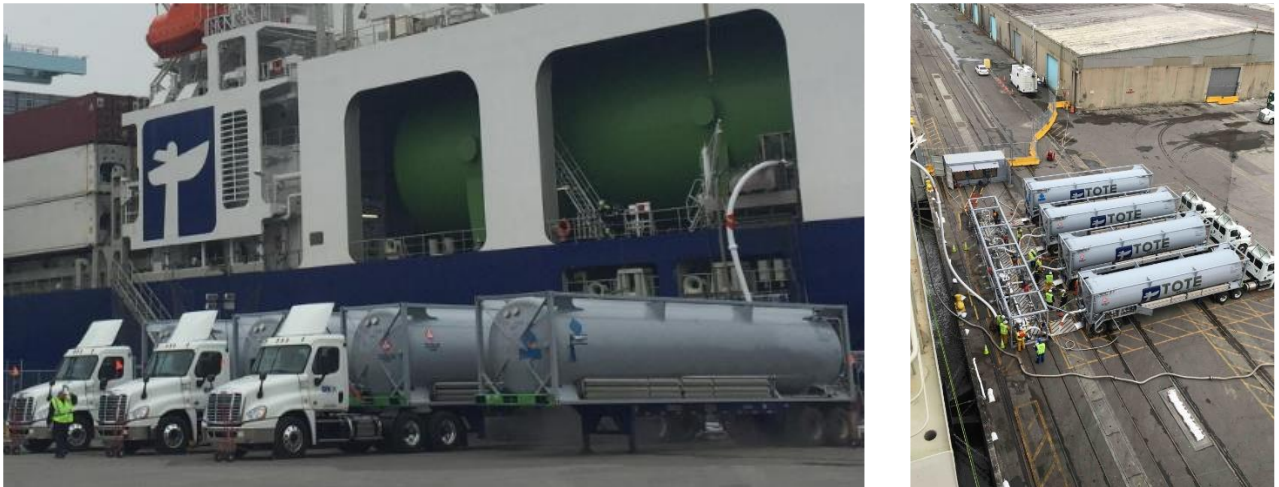
Figura 17 - "Bateria" de contentores de GNL para abastecimento
