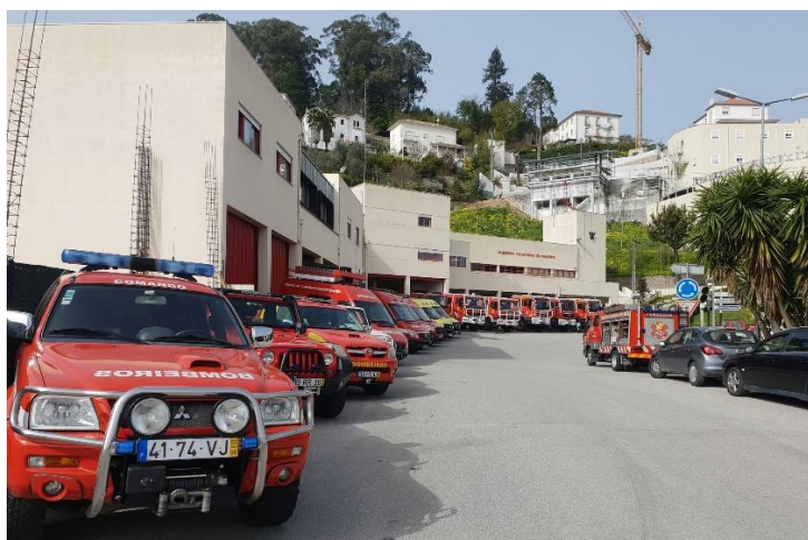
Figura 3.4 - Término da construção da última ampliação, concluída em 2021 (BVP, 2025).
