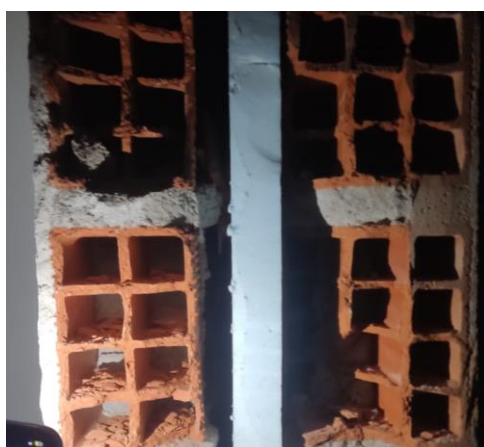
Figura 3.21 - Composição das paredes exteriores do edifício B, captada durante a última obra de expansão.
