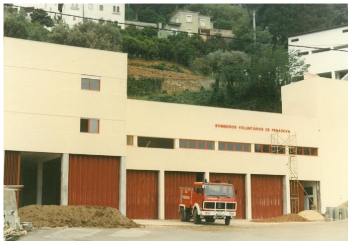
Figura 3.2 - Construção da primeira fase do atual quartel, inaugurada em 1996. (BVP, 2025).
