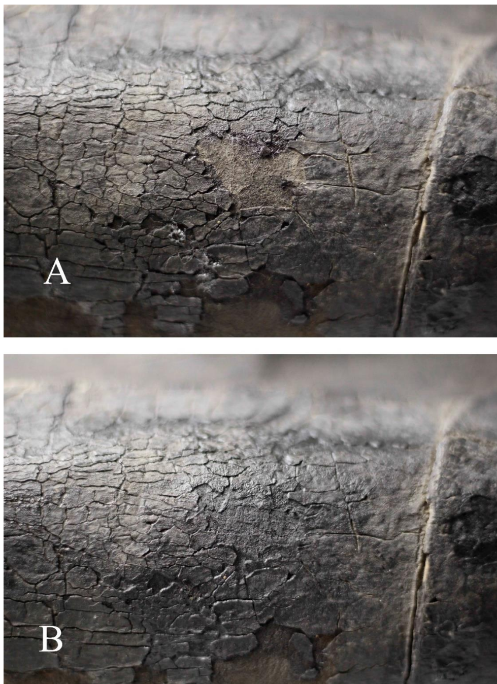
Figura 44- Fundo da MRa antes (A) e após preenchimento e reintegração (B). Elaboração própria.
