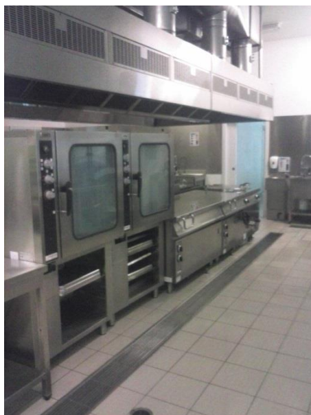
Figura 47- Imagens da cozinha
