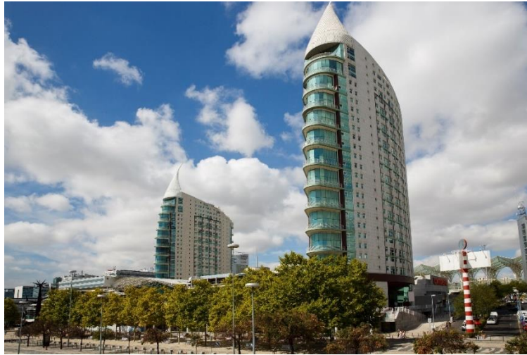
Figura 2.2 - Exemplos de estruturas mistas em Portugal (Torres de São Gabriel e São Rafael, Parque das Nações, Lisboa) [6].
