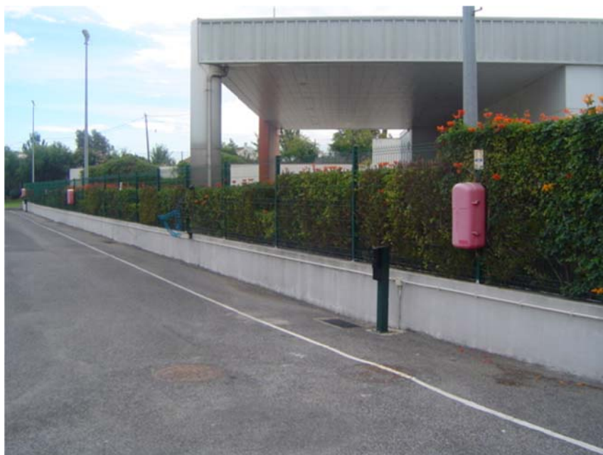
Figura 3.5 – Extintores de CO 2
