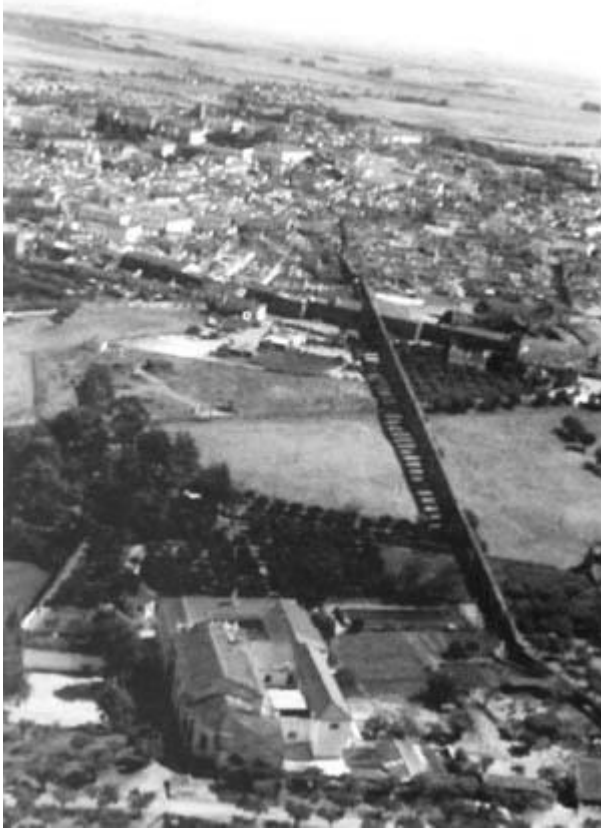
Fig.37. O aqueduto a penetrar na cidade de Évora.
