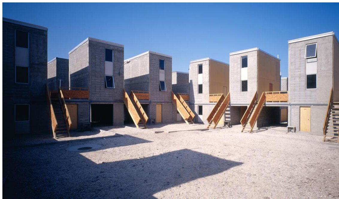
Fig,67. As várias fases de construção do bairro Quinta Monroy.
