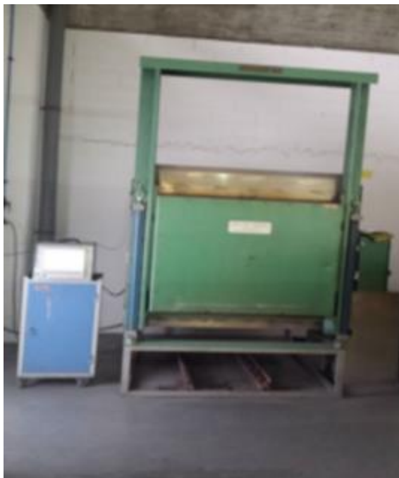
Figura 32 - Forno elétrico de tratamento da chapa utilizada para ensaio prático.
