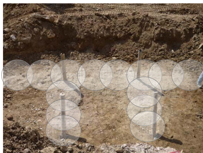
Figura 3.42 - Representação esquemática da localização das colunas de jet grouting no solo.
