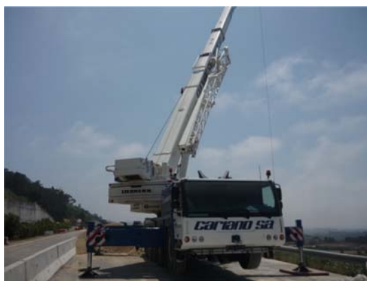
Figura 3.17 – Grua móvel Liebherr LTM 1160-5.1 .
