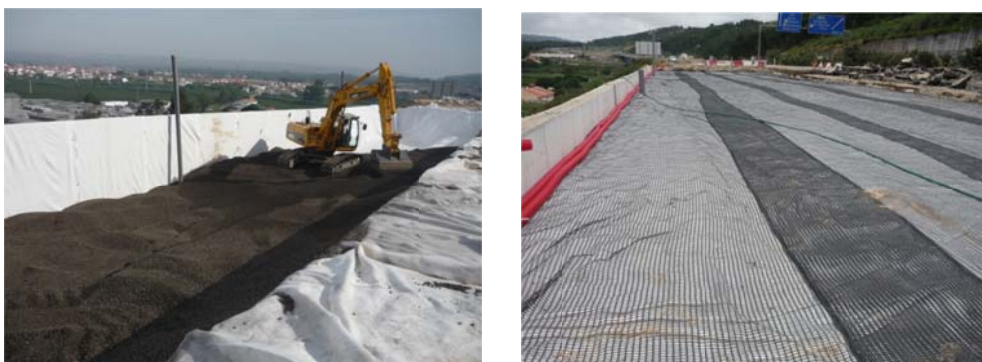
Figura 3.66 – Execução do aterro com geoleca (esquerda) e aplicação da geogrelha biaxial (direita).
