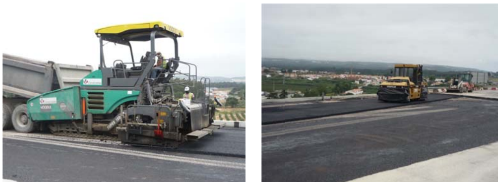
Figura 3.68 – Aplicação do macadame betuminoso e posterior compactação.
