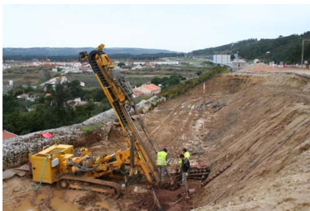
Figura 3.25 – Introdução da armadura principal no furo.
