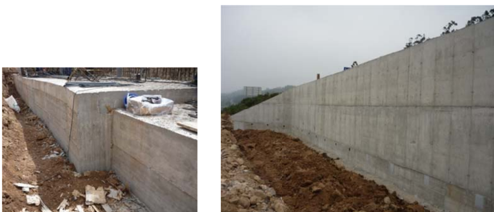
Figura 3.50 – Pormenor da base (esquerda) e aspecto final do muro (direita).
