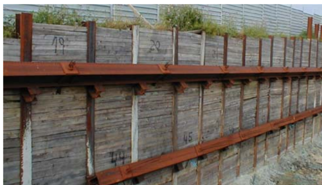
Figura 2.20 – Exemplo de uma parede tipo Berlim [34].
