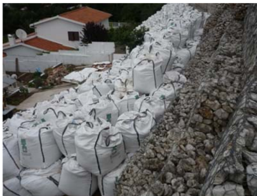
Figura 3.19- Imagem dos big bags colocados posteriormente na zona Sul do talude.
