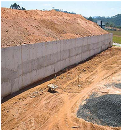
Figura 2.18 – Exemplo de muro de suporte em consola [30].
