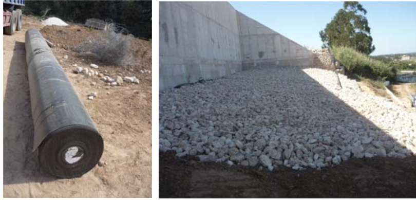
Figura 3.58 – Pormenor da tela PEAD (esquerda) e vista geral da pedra arrumada sobre o talude (direita).
