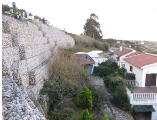
Figura 3.9 – Imagem do muro de gabiões, anterior aos trabalhos de estabilização.
