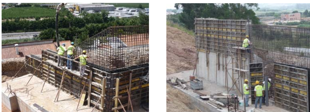
Figura 3.49 – 1ª e 2ª fase de betonagem do muro de betão armado.
