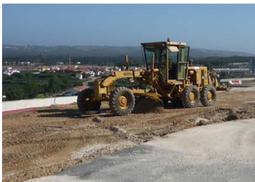
Figura 3.67 – Execução da distribuição e nivelamento do agregado britado.
