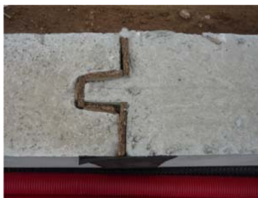
Figura 3.48 – Pormenor da junta de dilatação.
