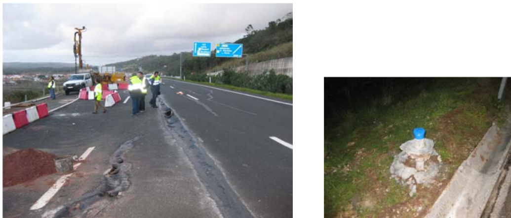
Figura 3.1 – Imagens da zona de crista do talude em Fevereiro de 2010.
