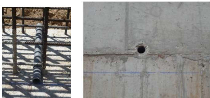
Figura 3.53 – Pormenor de bueiro na fase anterior (esquerda) e posterior (direita) à betonagem do muro.
