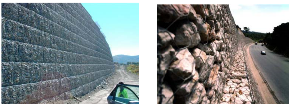
Figura 2.14 – Exemplo de aplicação (esquerda) e pormenor dos degraus [27] (direita).
