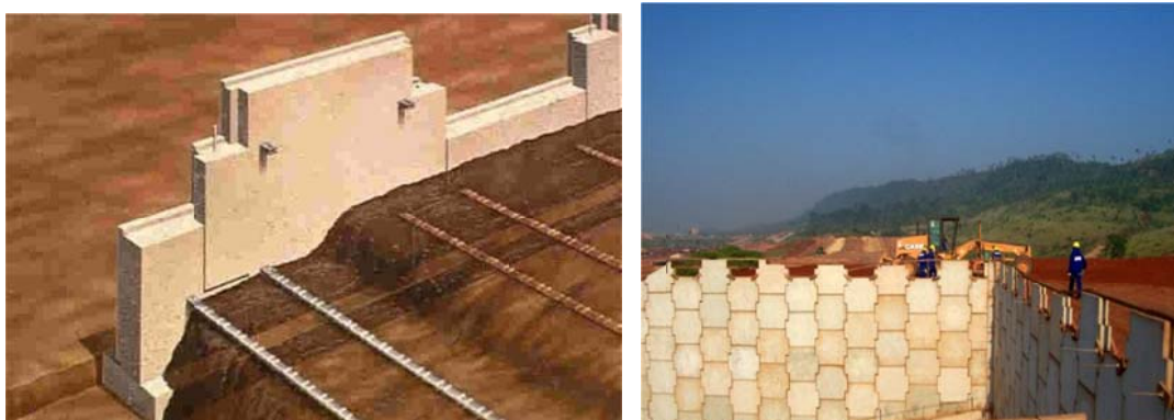
Figura 2.19 – Exemplo de bandas metálicas dispostas no muro (esquerda) e aspecto final (direita) [31].
