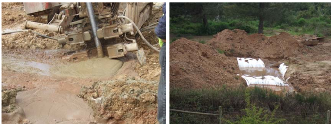
Figura 3.39 – Refluxo proveniente da injeção (esquerda) e depósito de refluxo (direita).
