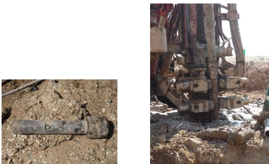
Figura 3.40 – Adaptador de perfuração (esquerda) e execução de uma microestaca vertical (direita).
