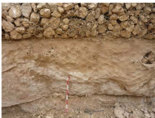
Figura 3.13 – Pormenor da manta geotêxtil encontrada durante a escavação.
