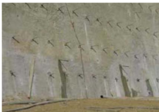
Figura 2.25 – Exemplo de aplicação de drenos horizontais profundos [40].
