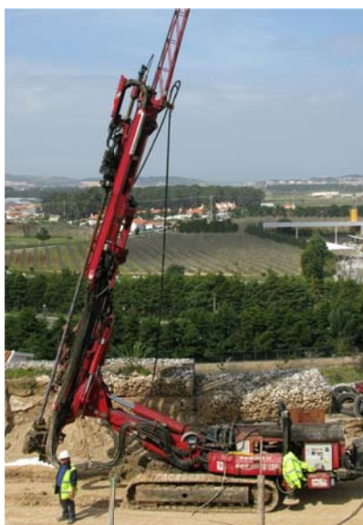
Figura 3.29 – Máquina de furação e injeção EGT MD 5200 .
