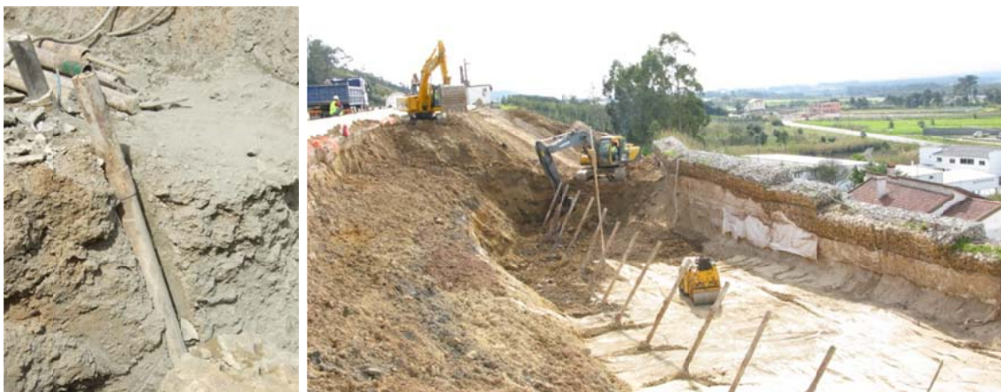
Figura 3.27 - Imagens da escavação até à cota da sapata do muro de betão armado.
