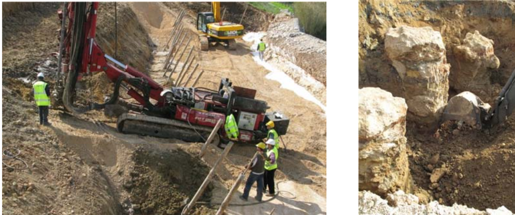
Figura 3.33 – Execução de colunas de ensaio da zona 1 (esquerda) e posterior escavação (direita).
