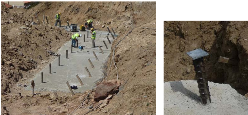
Figura 3.43 – Betão de limpeza e pormenor de uma microestaca com hélice e chapa metálica.
