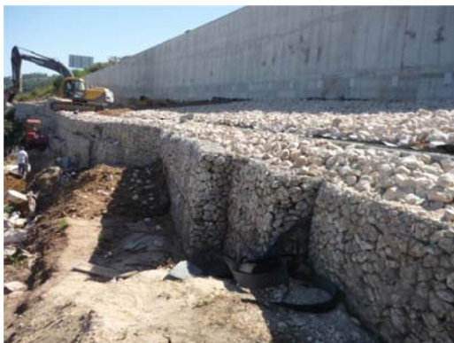
Figura 3.10 – Imagem do muro de gabiões, posterior aos trabalhos de estabilização.
