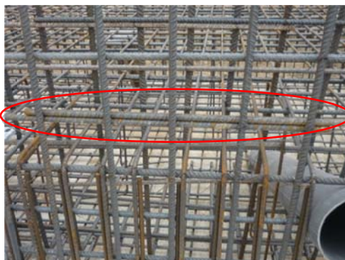
Figura 3.51 – Pormenor de emendas de armaduras.
