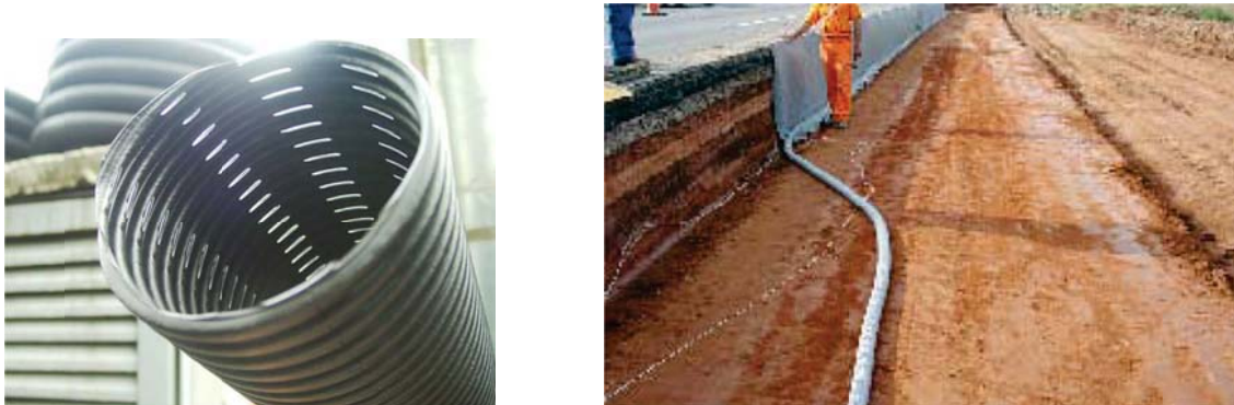
Figura 2.26 – Pormenor de um tubo drenante e exemplo de aplicação [41].
