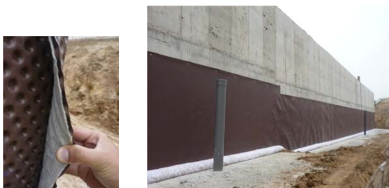
Figura 3.54- Imagens da constituição (esquerda) e aplicação da tela drenante (direita) enkadrain .
