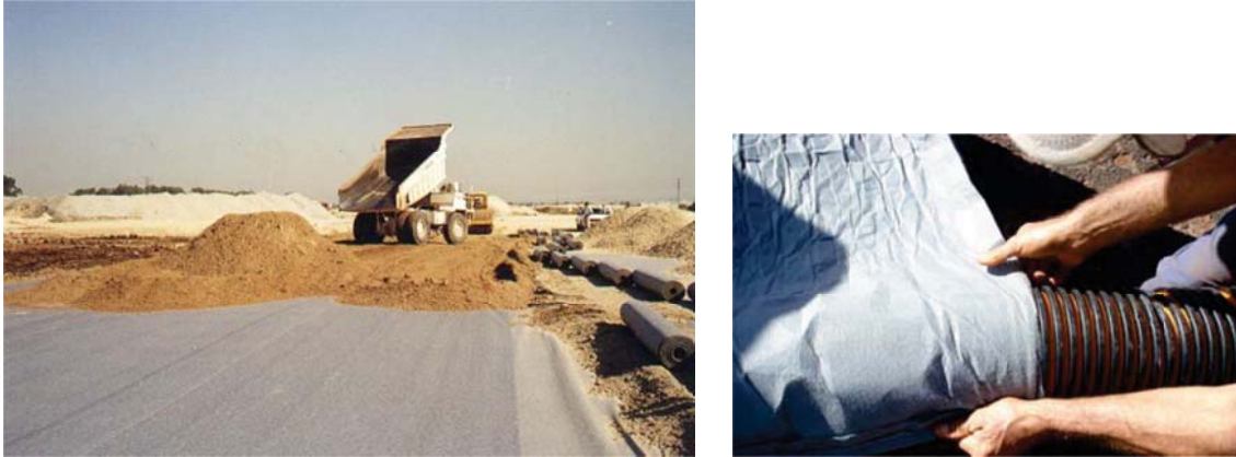
Figura 2.27 – Exemplos de aplicação de mantas geotêxteis [43].
