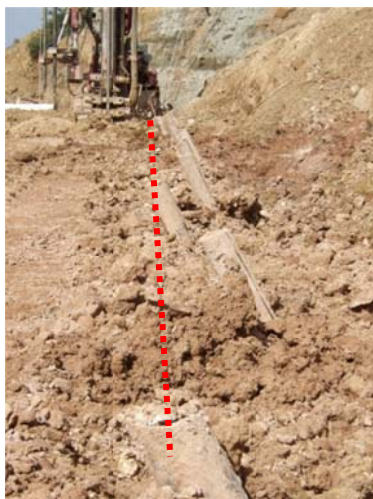
Figura 3.28 – Imagem das microestacas inclinadas.
