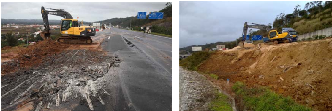
Figura 3.23 - Remoção de parte da faixa de rodagem (esquerda) e nivelamento do terreno (direita).
