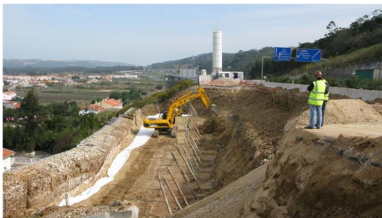
Figura 3.37 – Nivelamento do terreno para a execução de colunas de jet grouting.
