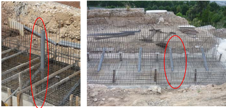
Figura 3.47 – Pormenor da instalação de calha inclinométrica e de negativos para ancoragens.
