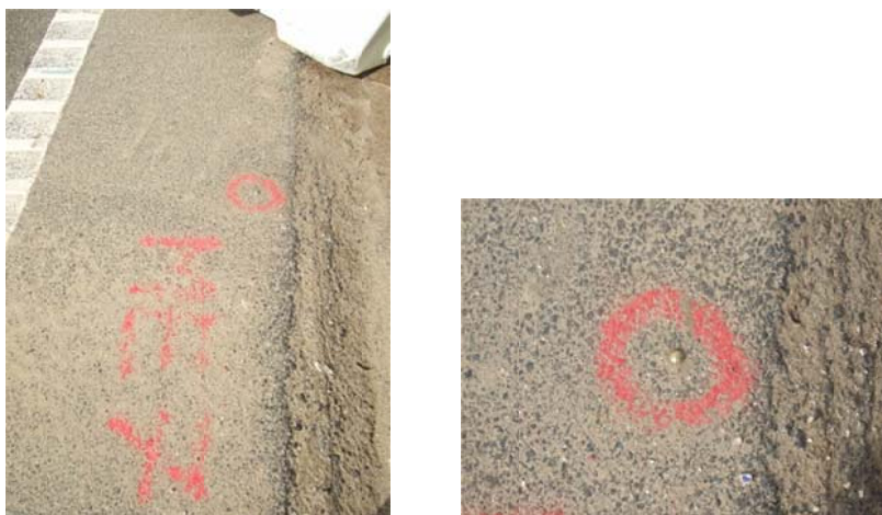
Figura 4.8 – Imagem de uma marca de superfície aplicada no pavimento.
