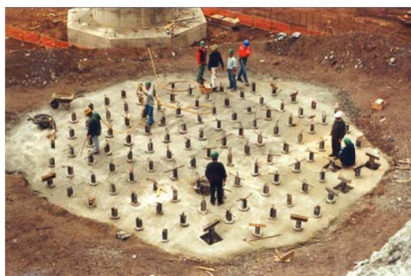
Figura 2.4 – Microestacas como elementos de fundação [24].
