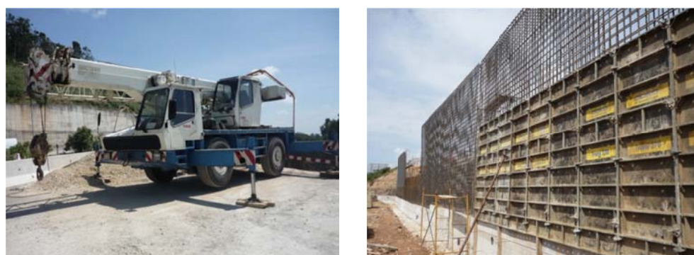
Figura 3.45 – Grua móvel (esquerda) e cofragem Frami 270 (direita).
