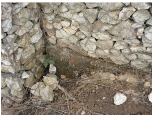
Figura 3.14 – Base do muro de gabiões.
