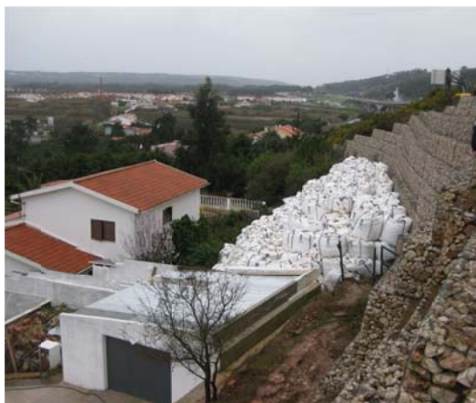
Figura 3.18 – Imagem dos big bags colocados na zona Norte do talude.
