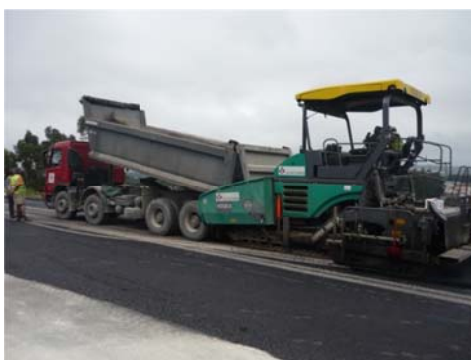
Figura 3.64 - Pavimentadora de lagartas VOGUELE 1800-2 e compactador de pneus CAT PS-360C .
