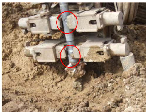
Figura 3.38 – Pormenor dos bicos de injeção da máquina de jet grouting.
