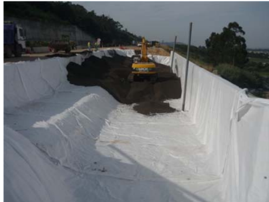
Figura 3.56 – Geotêxtil de separação do material de aterro.
