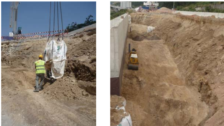
Figura 3.65 – Trabalhos de despejo dos big bags (esquerda) e de compactação (direita).
