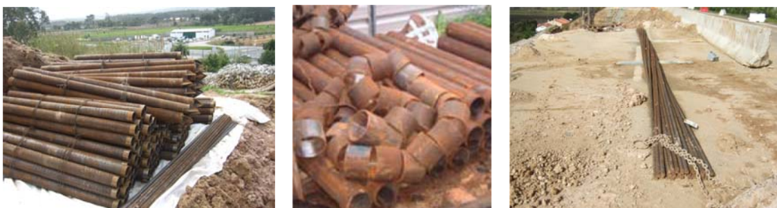
Figura 3.21 - Tubos N80 (esquerda), uniões exteriores (centro) e varões Ø32mm A500/550 (direita).
