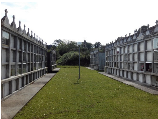
Fig. 122. Vista de la terminación de la ampliación del cementerio.
