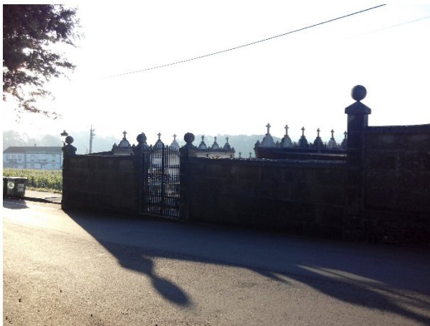
Fig. 116. Fachada de la primera ampliación del cementerio existente.
