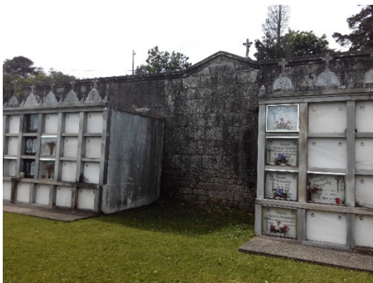
Fig. 121. Espacios vacíos entre panteones.
