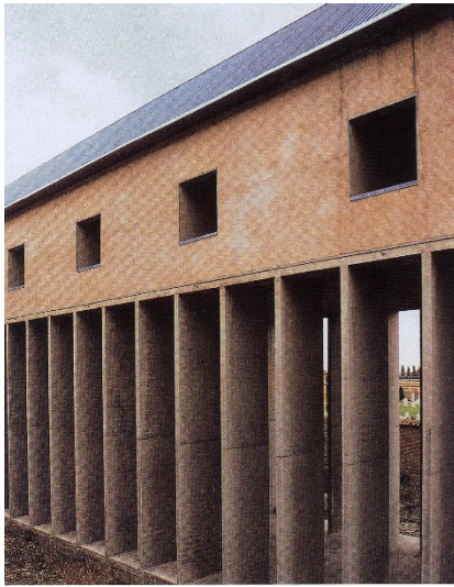
Fig. 10. Espacio porticado con huecos sin ventanas ni puertas.
