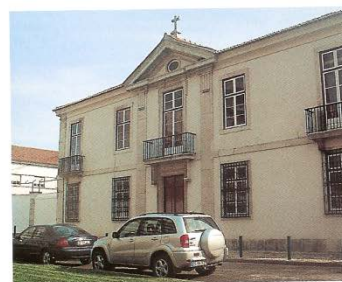
QUINTA DA ALFAROQUEIRA - 2005 Integrada hoje na cidade, esta quinta de veraneio do Arquitecto de Mafra é um exemplo da arquitectura urbana civil de antes do terramoto. Refuncionalizada conserva a sua estrutura e sobriedade artística indomita.
