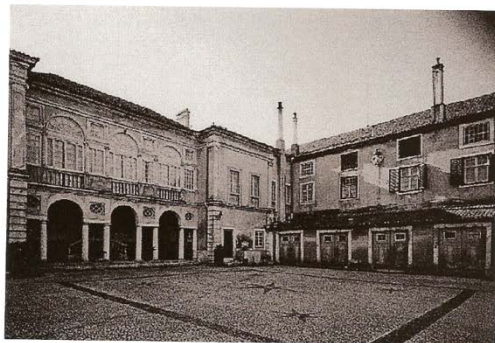
PALÁCIO DOS MARQUES DA FRONTEIRA – 1940-1949 Pátio de entrada
