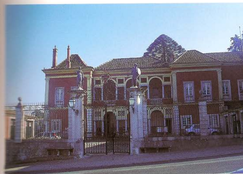
PALÁCIO DOS MARQUES DA FRONTEIRA Construído entre o séc XV e XVII, a sua fachada principal, voltada à estrada, é valorizada pelo pórtico brasonado, a galeria para o pátio de honra e vestibulo. Todo o conjunto em cor almagre que faz sobressair o revestimento azulejar é estupendo a deixar adivinhar o traçado dos jardins.
