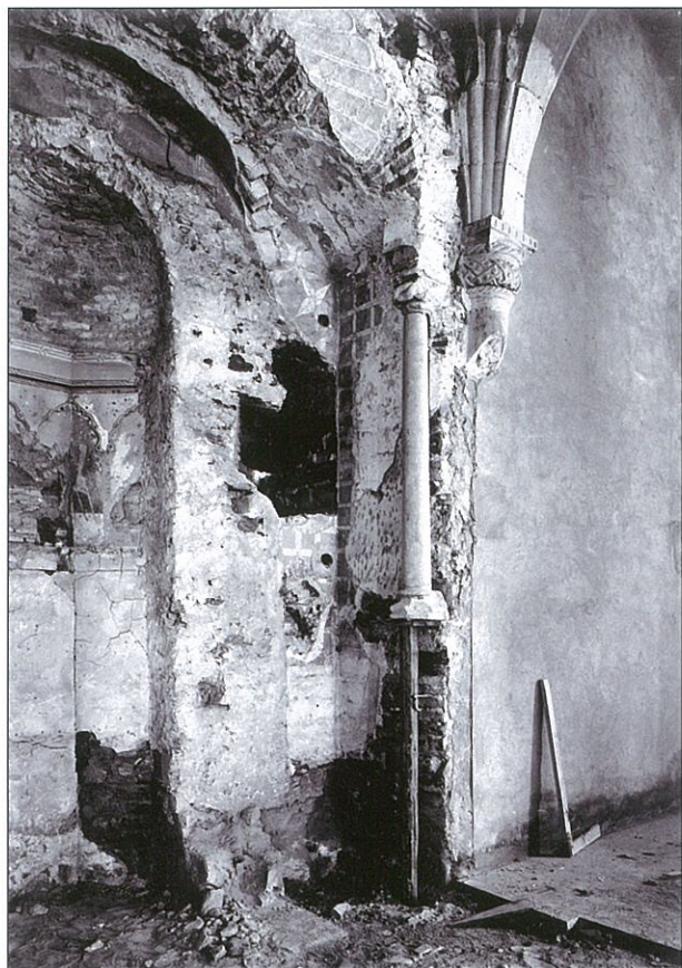
Figura 14. Fotografía de la DGEMN durante las obras de mediados del siglo XX, en la que es visible el mihrāb y, junto al él, un hueco en se colocaría el mimbar móvil.
