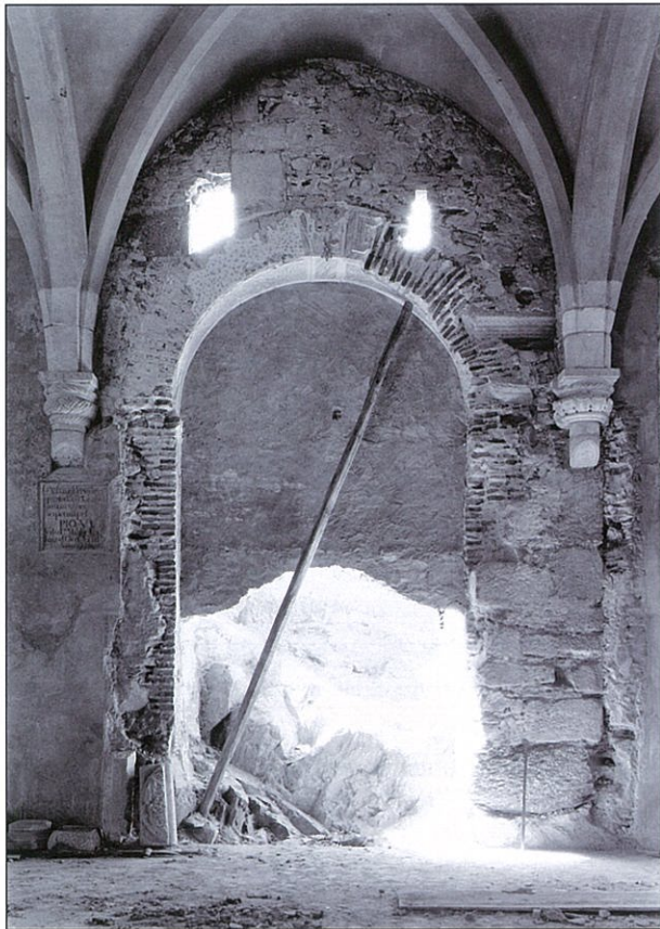
Figura 12. Vano situado en el muro opuesto a la qibla durante las obras de la DGEMN.
