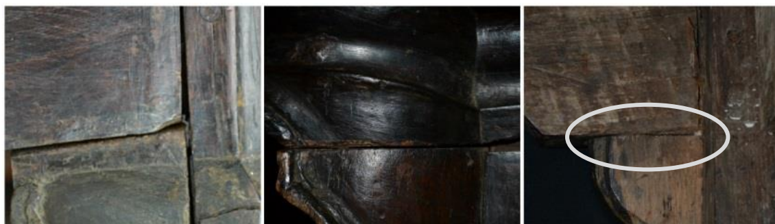
Fig. 92 – Falta de adesão entre peças coladas (espaços vazios, folgas): Pormenor de áreas onde se observa a falta de adesão entre as peças que conformam a mesa e sua decoração. Fonte: de elaboração própria.
