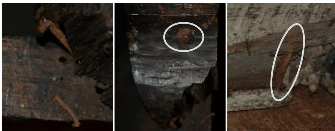
Fig. 93 – Elementos metálicos oxidados e corroídos: Pormenores dos pregos oxidados e corroídos, dispersos por várias áreas da mesa. Fonte: de elaboração própria.
