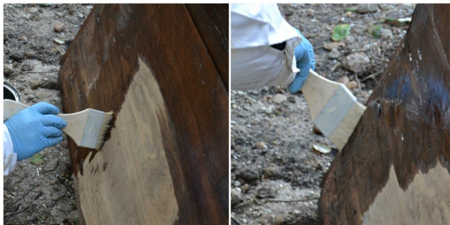
Fig. 7 – Aplicação do produto para desinfestação das madeiras. Fonte: de elaboração própria.
