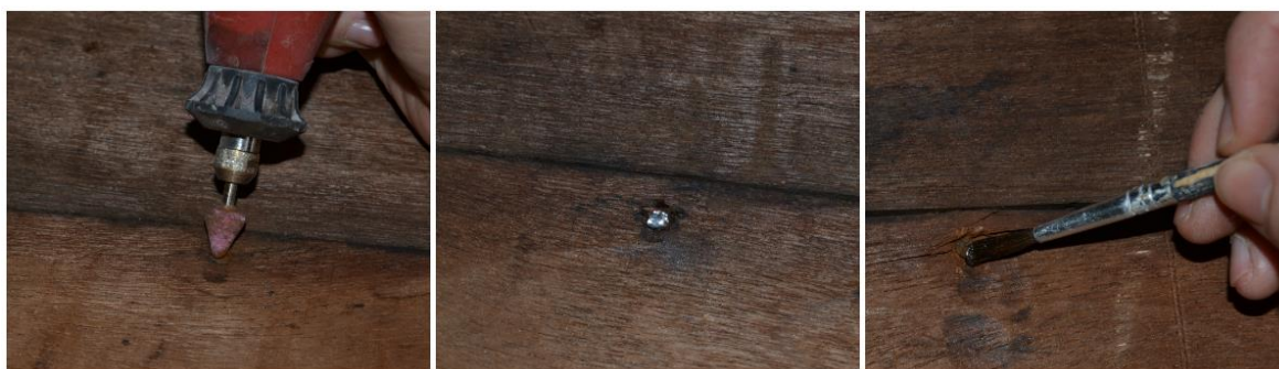
Fig. 115 – Desoxidação dos elementos metálicos oxidados impossíveis de remover e aplicação de ácido tânico a 10% em álcool com auxílio de um pincel fino. Fonte: de elaboração própria.
