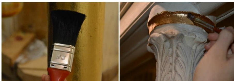
Fig. 7 – Aplicação do estrato de proteção sobre o douramento. Fonte: de elaboração própria.
