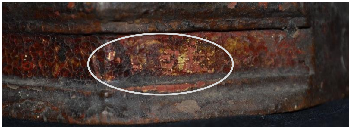
Fig. 36 – Lacunas ao nível da camada de proteção: Pormenor onde se observa as camadas subjacentes à camada de proteção (vista lateral esquerda da base). Fonte: de elaboração própria.
