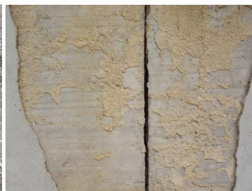
Figura 4.32 - Nível 3 - Escola básica Alto da Faia - muro exterior
