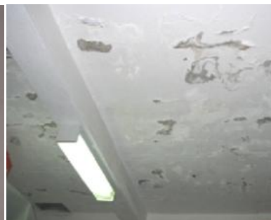
Figura 4.68 - Nível 3 - Escola Secundária de Santo André - pintura em teto rebocado no interior do edifício (Barrelas, 2012)
