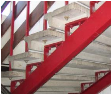
Figura 4.6 - Nível 1 - Escola Secundária Professor Ruy Luís Gomes - escadas interiores em betão (Barrelas, 2012)
