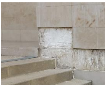
Figura 4.39 - Nível 1 - Escola básica Alto da Faia - revestimento em pedra de parede da casa das máquinas
