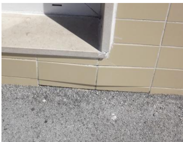
Figura 4.63 - Nível 1 - Escola básica Alta de Lisboa - revestimento cerâmico de parede exterior
