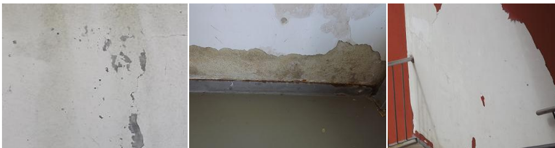
Figura 4.24 - Nível 1 - Escola básica Alta de Lisboa - muro exterior
