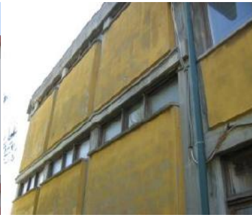
Figura 4.8 - Nível 3 - Escola Secundária de Santo André - parede exterior em alvenaria de tijolo furado rebocada (Pereira, 2012)
