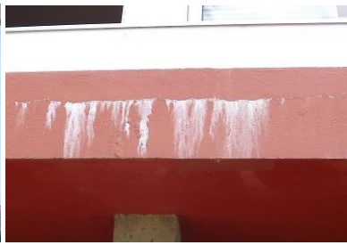
Figura 4.55 - Nível 2 - Escola básica Alto da Faia - fachada do Jardim de Infância
