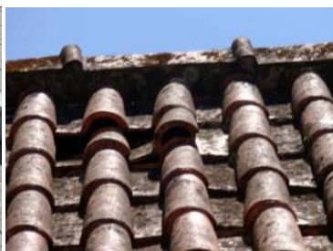
Figura 4.38 - Nível 3 - Escola Secundária Ferreira Dias - revestimento de cobertura inclinada em telha cerâmica (Pereira, 2012)
