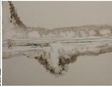
Figura 4.13 - Nível 2 - Escola básica Alto da Faia - teto falso da entrada principal
