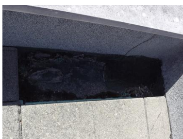
Figura 4.40 - Nível 2 - Escola básica Alta de Lisboa - revestimento da cobertura,sobre tela de impermeabilização
