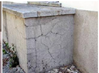
Figura 4.17 - Nível 3 - Escola Secundária D. Manuel I - revestimento de soco em marmorite (Pereira, 2012)
