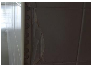
Figura 4.21 - Nível 1 - Escola básica Alta de Lisboa - revestimento cerâmico da parede e cantoneira
