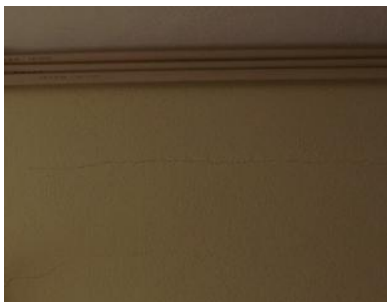
Figura 4.18 - Nível 1 - Escola básica alta de Lisboa - arrecadação de sala de aula
