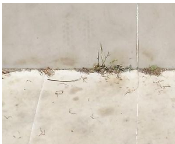
Figura 4.57 - Nível 1 - Escola básica Alto da Faia - lancil junto da entrada principal
