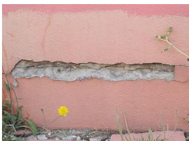
Figura 4.22 - Nível 2 - Escola básica Alto da Faia – muro da fachada norte
