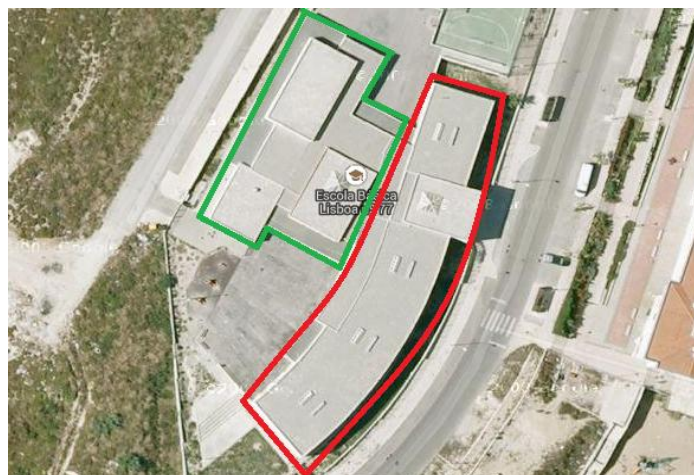
Figura 3.11 - Escola Básica da Alta de Lisboa: Delimitação do bloco A (vermelho); Delimitação do bloco B (verde) (fonte Google Earth , 2013)
