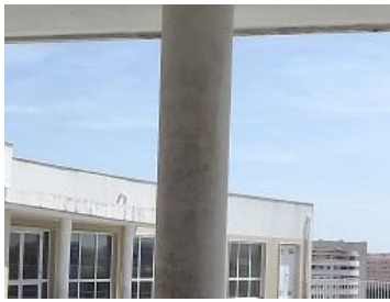
Figura 4.54 - Nível 1 - Escola básica Alta de Lisboa - pilar do recreio coberto
