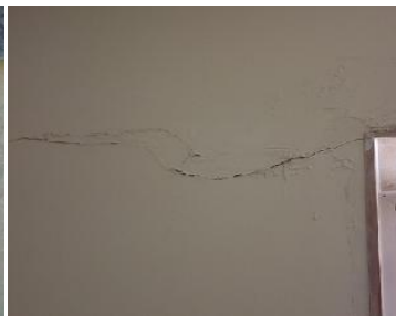
Figura 4.16 - Nível 2 - Escola básica Alta de Lisboa – corredor com rampa de acesso ao 2º piso
