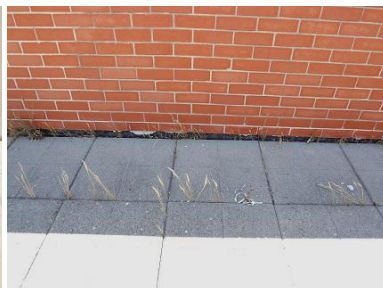
Figura 4.58 - Nível 2 - Escola básica Alta de Lisboa - cobertura em terraço
