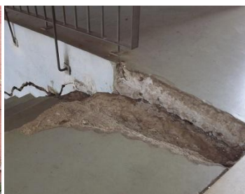
Figura 4.23 – Nível 3 - Escola básica Alto da Faia - escada de acesso ao campo de jogo
