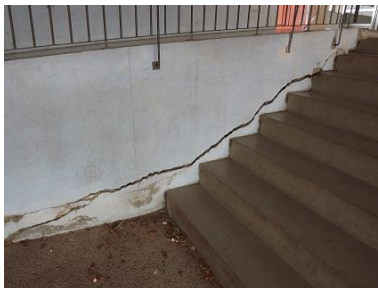
Figura 4.65 - Nível 3 - Escola básica Alto da Faia - escada de acesso ao campo de jogos
