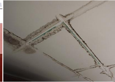
Figura 4.56 - Nível 3 - Escola básica Alto da Faia - teto da entrada principal
