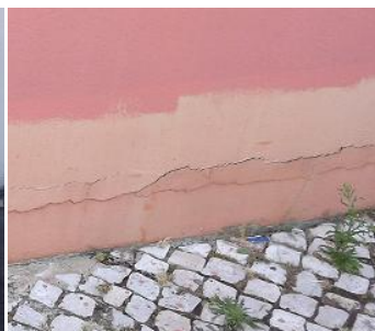
Figura 4.20 – Nível 3 - Escola básica Alto da Faia – muro da fachada norte
