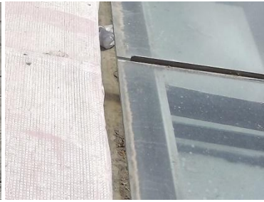
Figura 4.61 - Nível 2 - Escola básica Alto da Faia - caleira junto à cobertura de vidro
