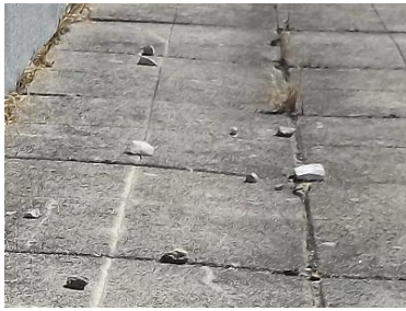
Figura 4.60 - Nível 1 - Escola básica Alta de Lisboa - cobertura em terraço
