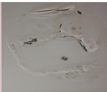
Figura 4.67 - Nível 2 - Escola básica Alto da Faia - teto do núcleo de escada junto ao campo de jogos
