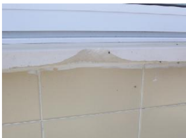
Figura 4.30 - Nível 1 - Escola básica Alta de Lisboa - parapeito de janela de sala de aula
