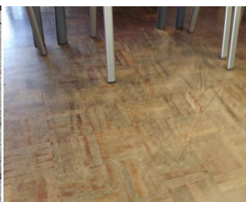
Figura 4.46 - Nível 2 - Escola básica Alto da Faia - revestimento em madeira do pavimento de sala de aula
