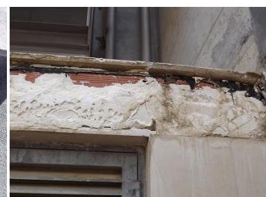
Figura 4.41 - Nível 3 - Escola básica Alta de Lisboa – Revestimento em pedra junto à tela de impermeabilização
