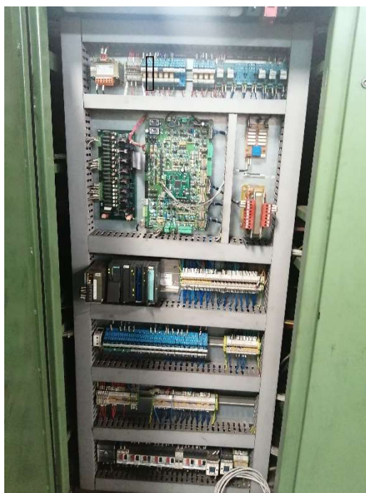
Figura 45 - Localização do fusível com maior temperatura
