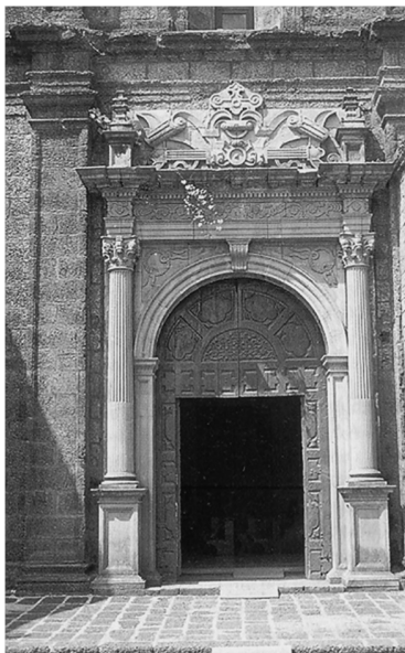
5. Pormenor da fachada da igreja do extinto Mosteiro de Santa Mónica, traça atribuída ao arquitecto Júlio Simonis ou Simão, c. 1606.
